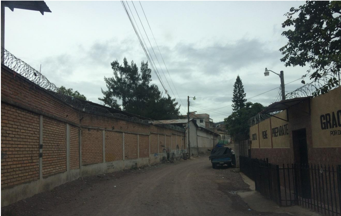
Tramo donde se colocara adoquin
