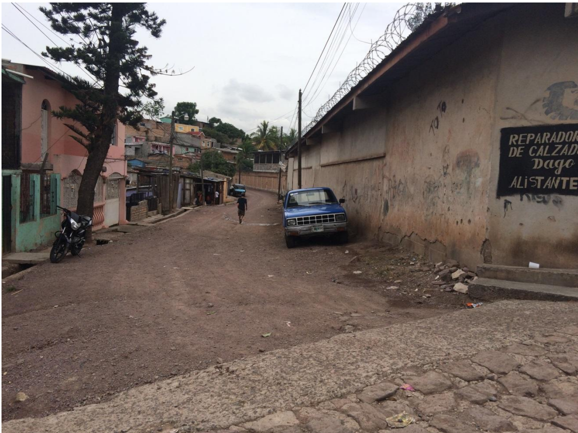
Final de calle a pavimentar
