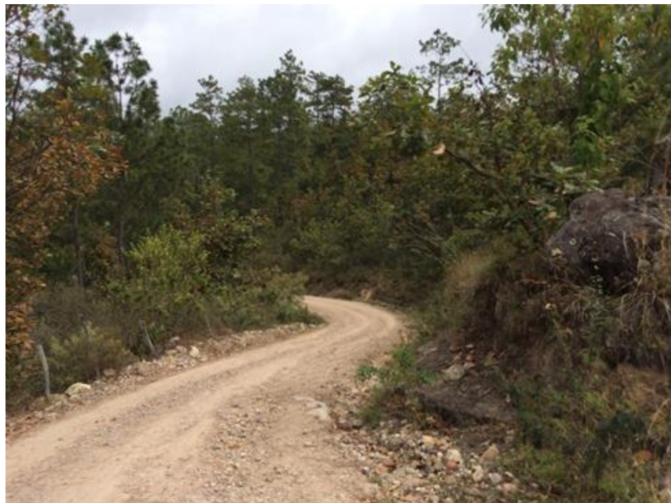
VISTA ACTUAL DE CALLE A REPARAR
