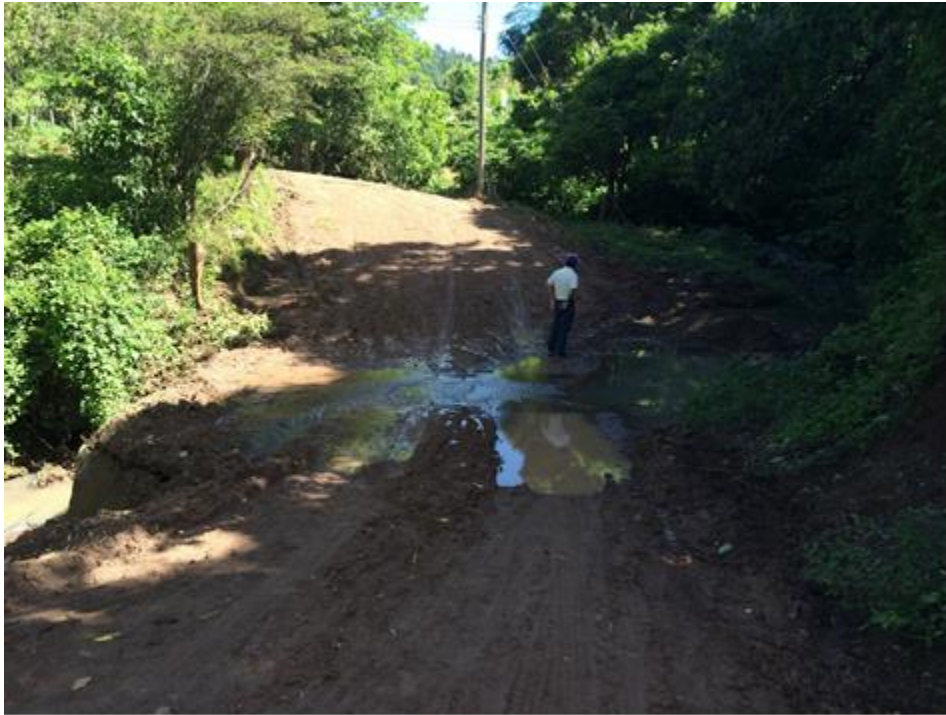
VISTA PANORÁMICA DE CALLE A REPARAR
