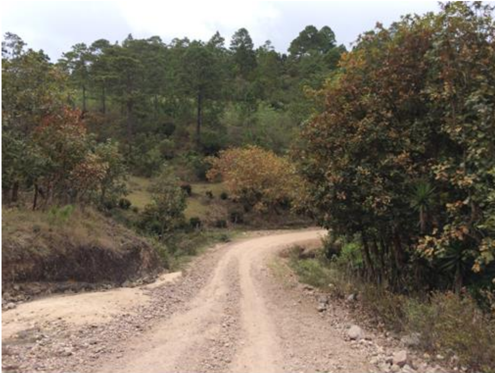
INICIO DE CALLE A REPARAR
