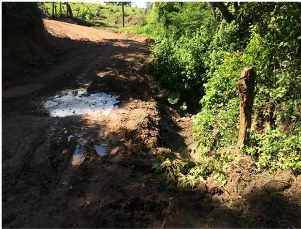
VISTA DE CALLE QUE REQUIERE BALASTADO
