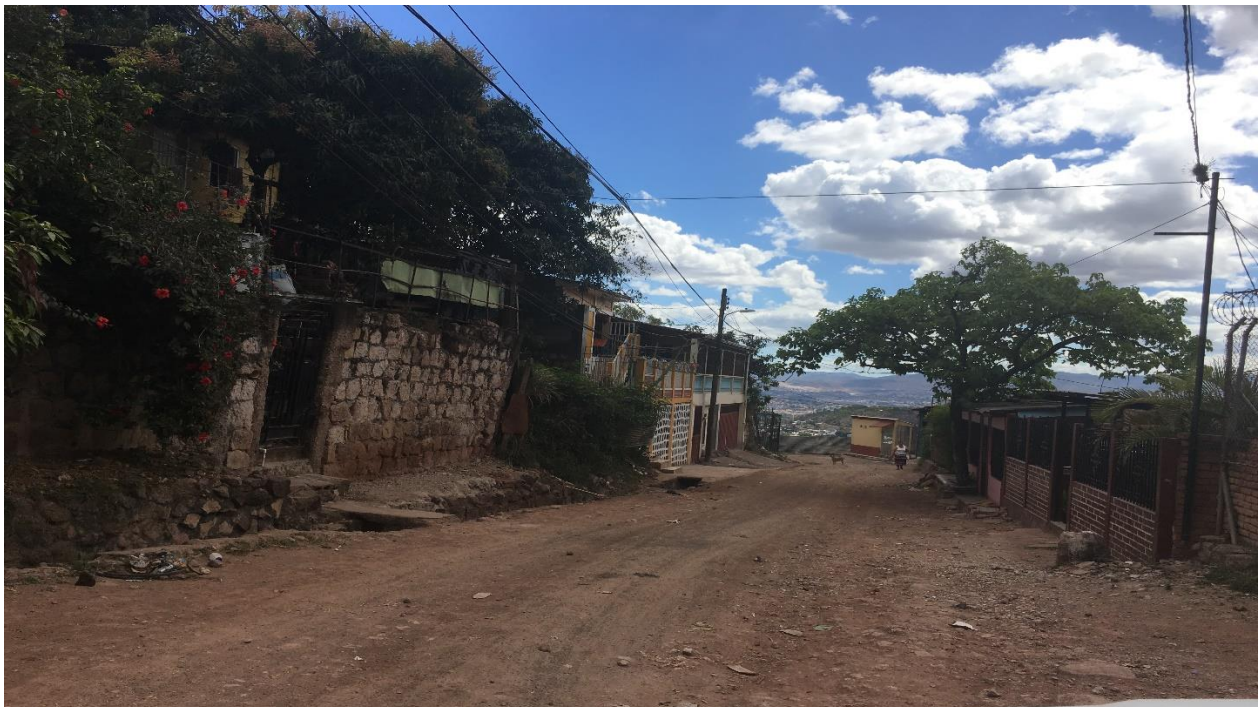
VISTA PANORÁMICA DE CALLE A PAVIMENTAR CON CONCRETO HIDRÁULICO
