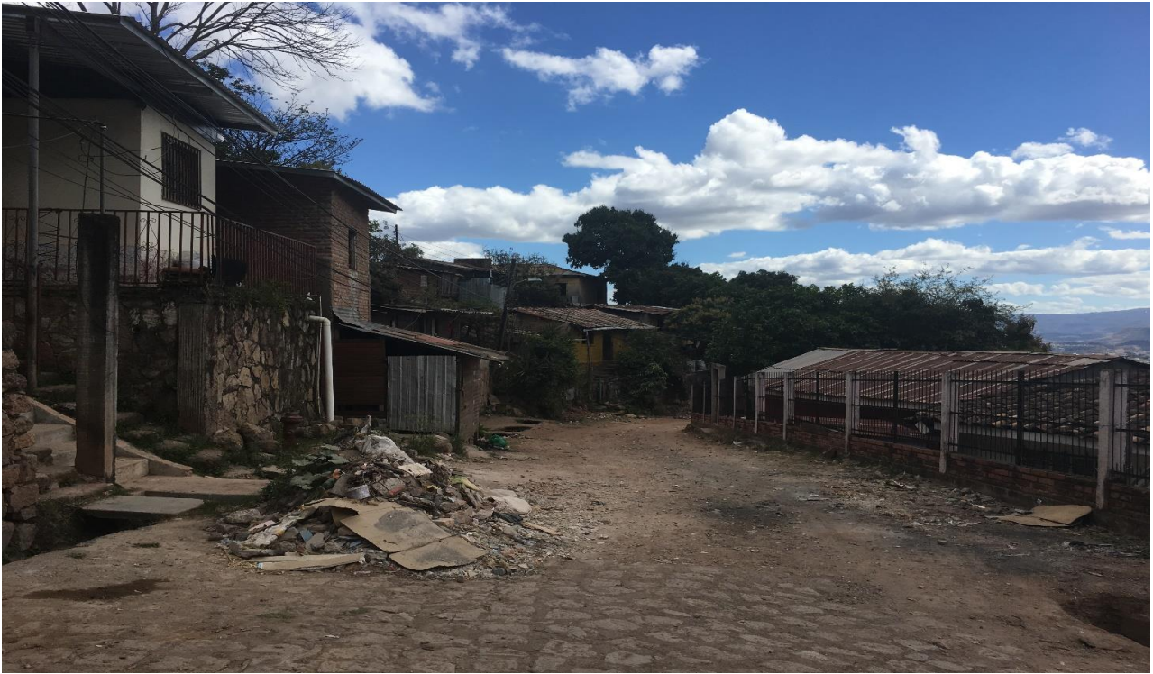
INICIO DE LA PAVIMENTACIÓN CON WHITE TOPPING
