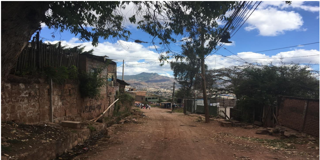
INICIO DE CALLE A PAVIMENTAR CON CONCRETO HIDRÁULICO
