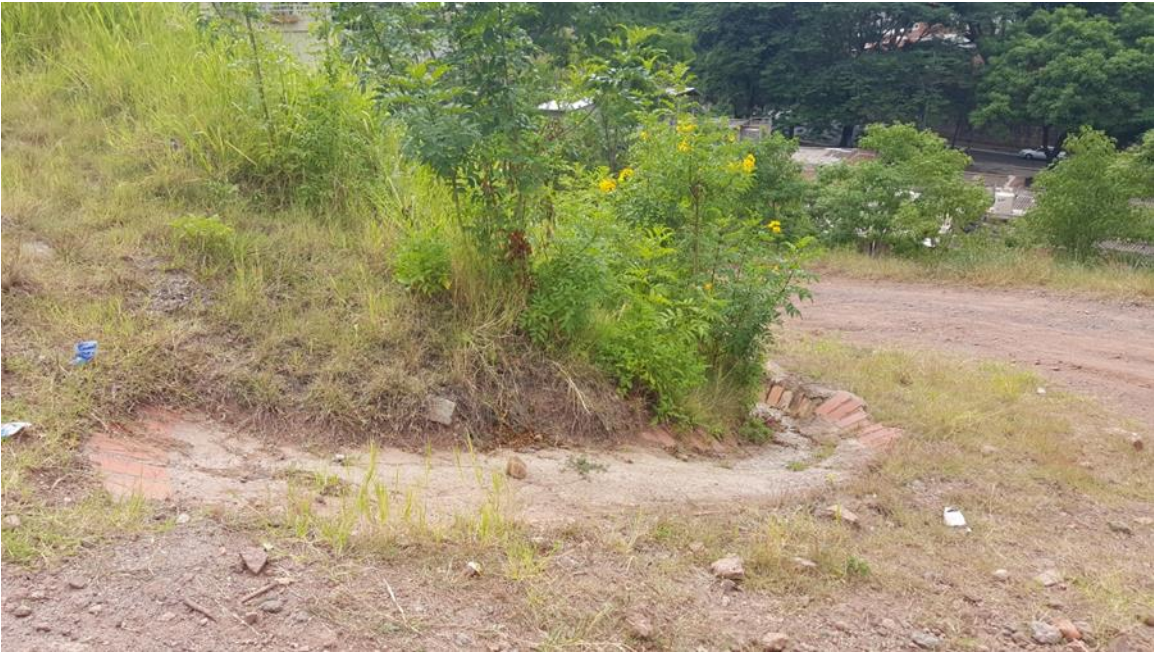
Vista panorámica de ubicación de cunetas
