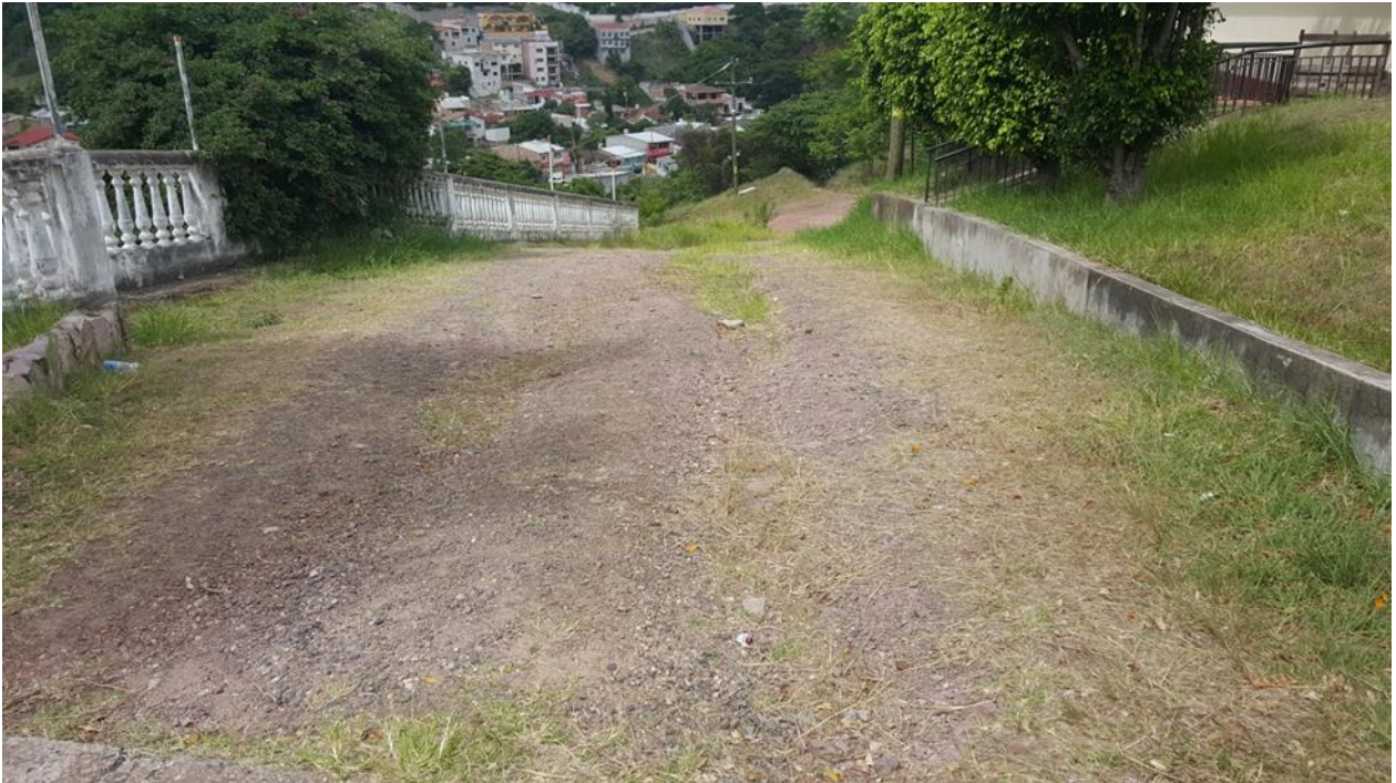
Inicio de proyecto de pavimentación
