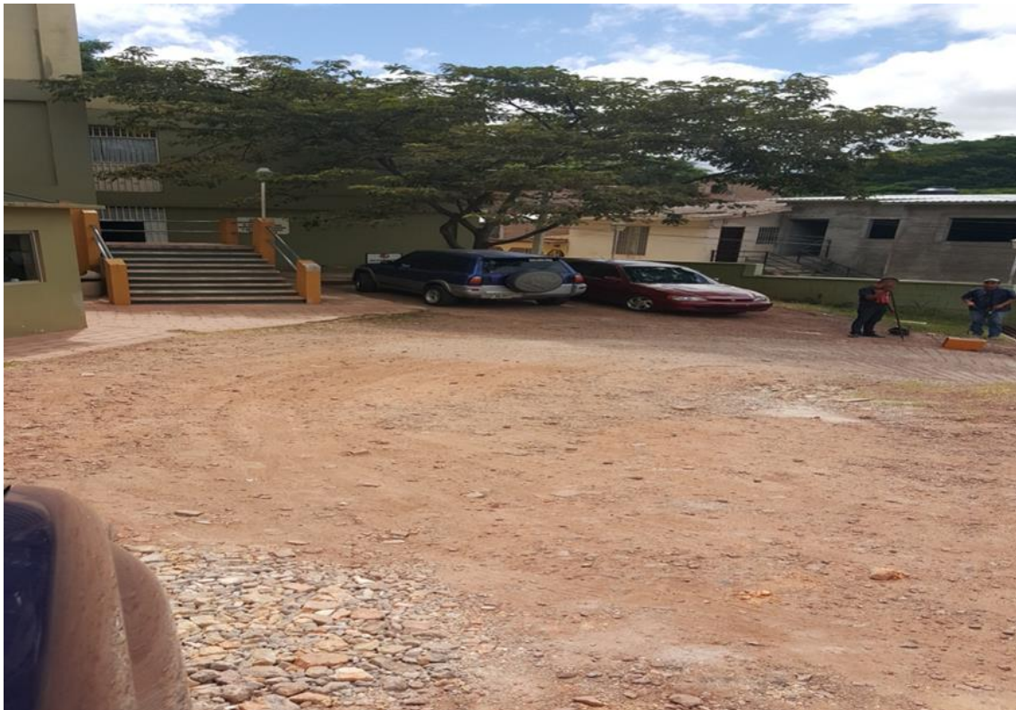
Final de proyecto de pavimentación
