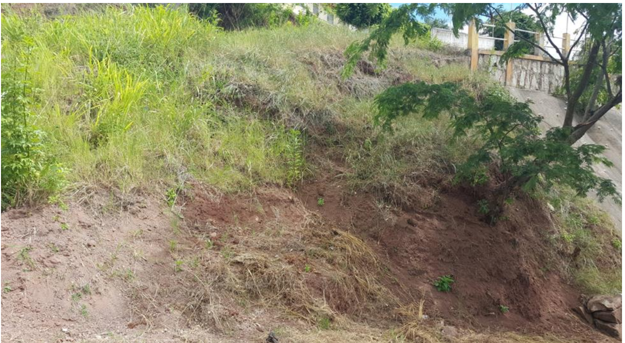
Ubicación de muro de contencion
