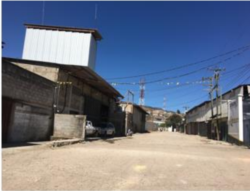
Foto No. 3: Vista de calle a pavimentar
