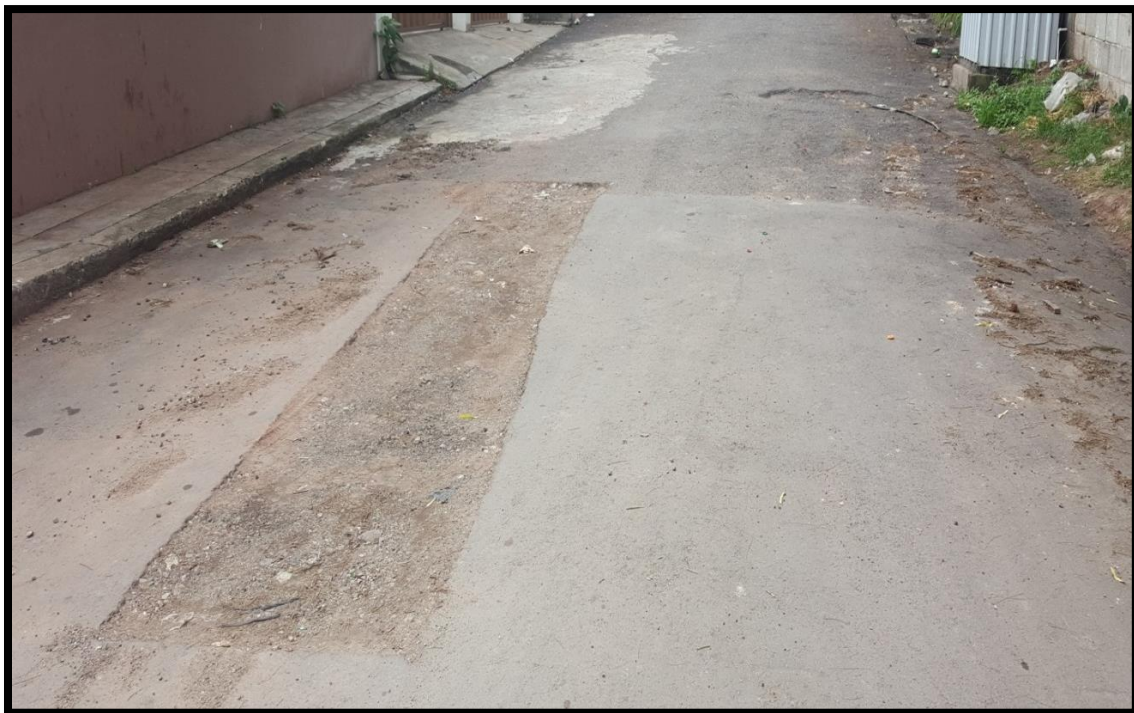
VISTA DEL INICIO DE LA REPARACIÓN
