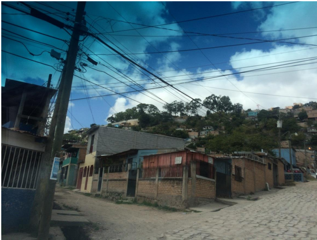
Foto No. 1: Inicio de calle "A"
