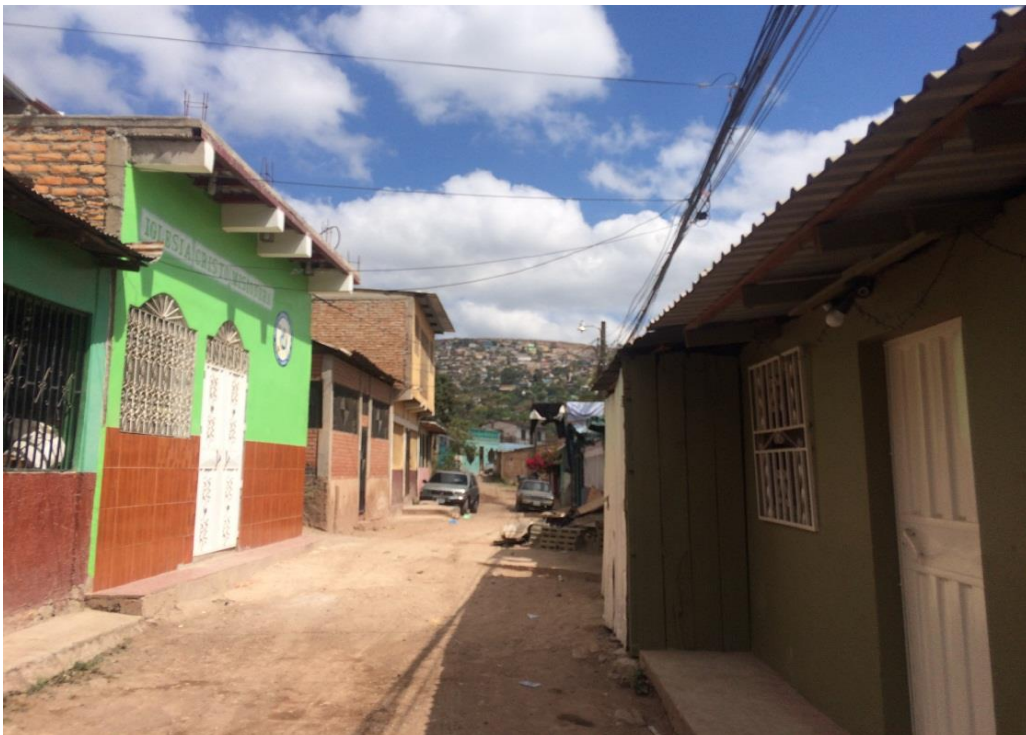
Foto No. 2: Estado actual de la calle "A"
