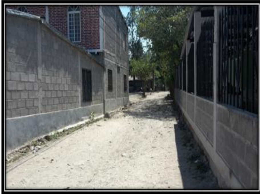
Foto No. 3: Vista panorámica de calle a pavimentar
