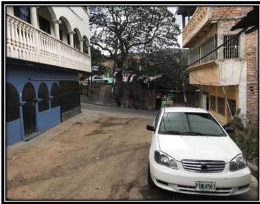
Foto No. 4: Final de calle "B"
