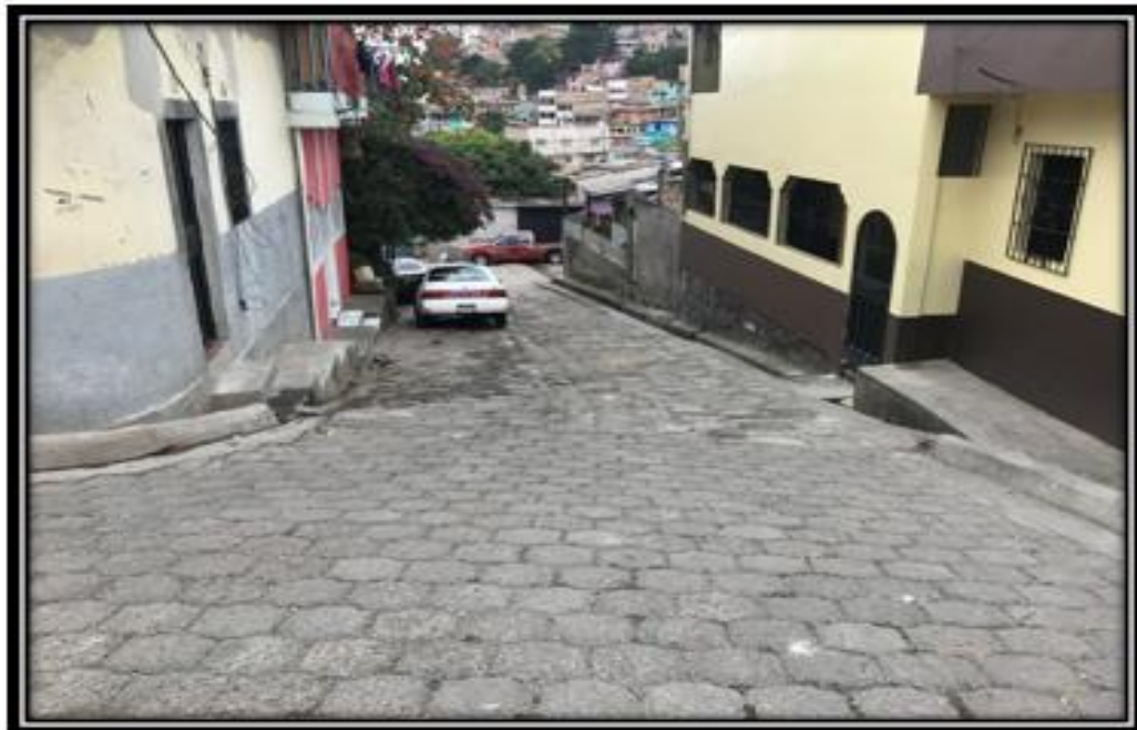
Foto No. 6: Final de desmontaje de adoquín "C"
