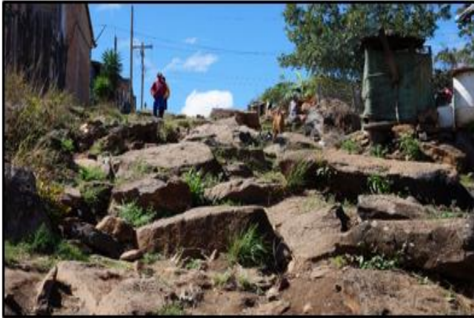
VISTA ACTUAL DE LA CALLE POR DONDE PASARÁ LA TUBERÍA
