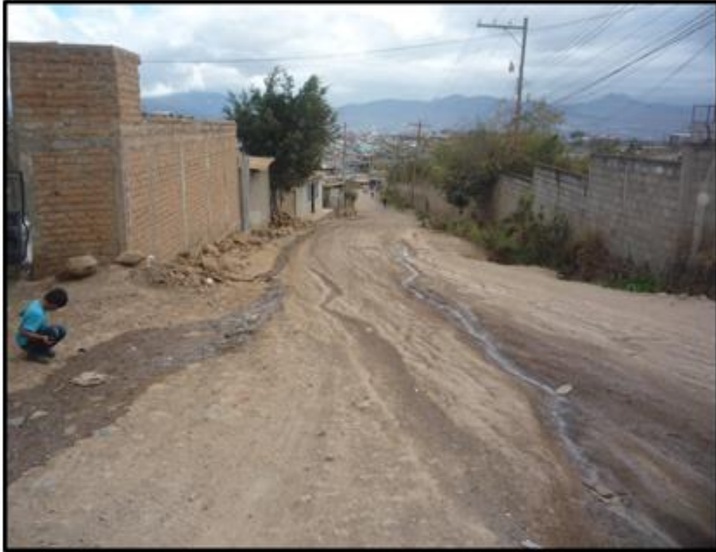
VISTA PANORÁMICA DEL FINAL DEL PROYECTO
