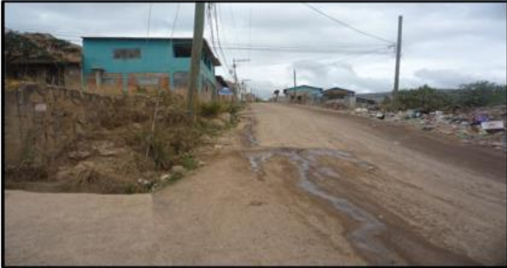
TRAMO DONDE SE INSTALARÁ LA TUBERÍA
