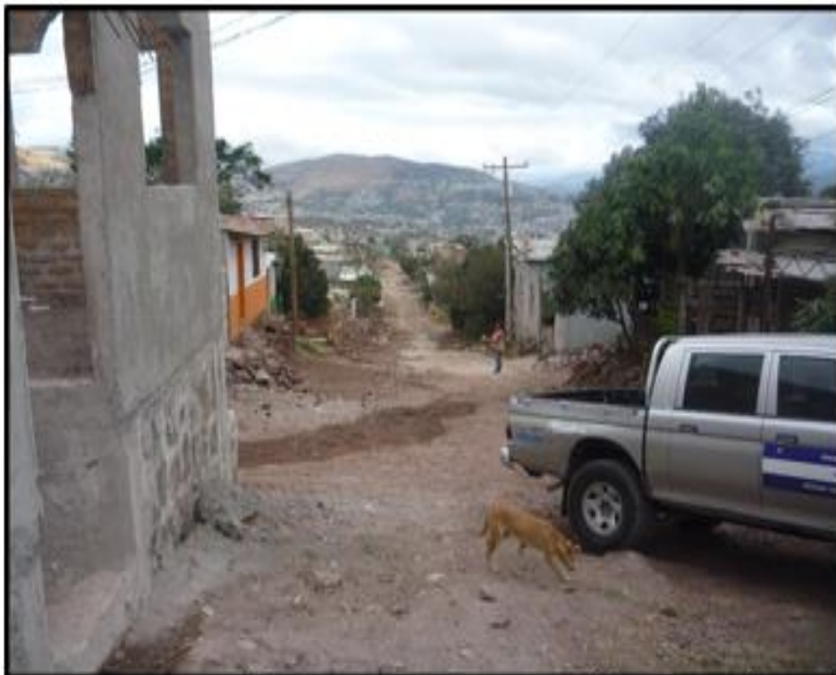
VISTA PANORÁMICA DONDE SE INSTALARÁ LA TUBERÍA
