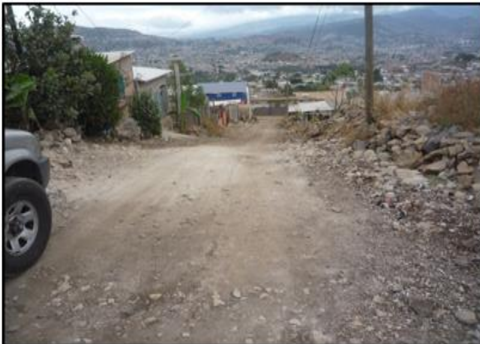
ZONA A EXCAVAR PARA LA INSTALACIÓN DE TUBERÍAS
