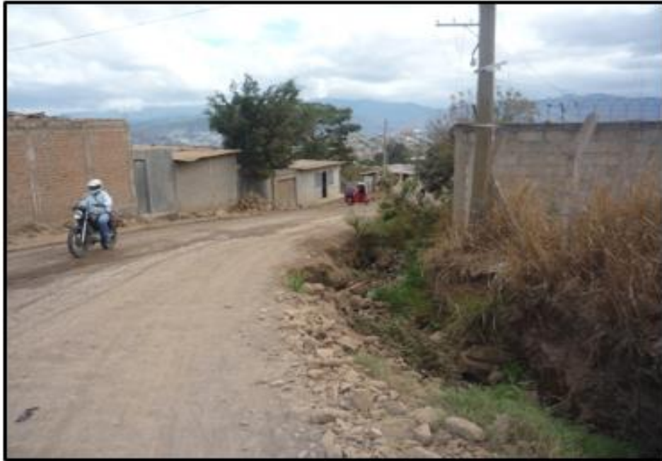
FINAL DE TRAMO EN QUE SE INSTALARÁN LAS TUBERÍAS
