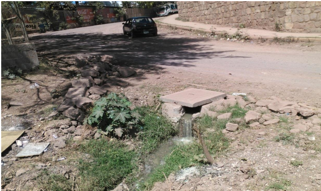
FOTO 2. PARTE CRITICA DE CALLE A PAVIMENTAR EN LA CUAL SE REQUIERE CONSTRUCCION DE TRAGANTES
