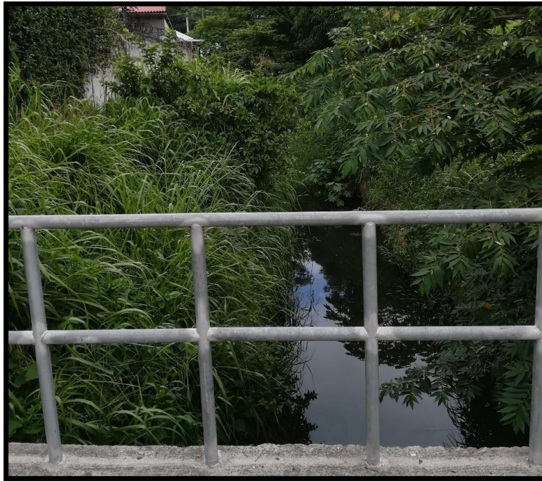
No. 1 Vista inicial del proyecto, parte de la quebrada a embaular
