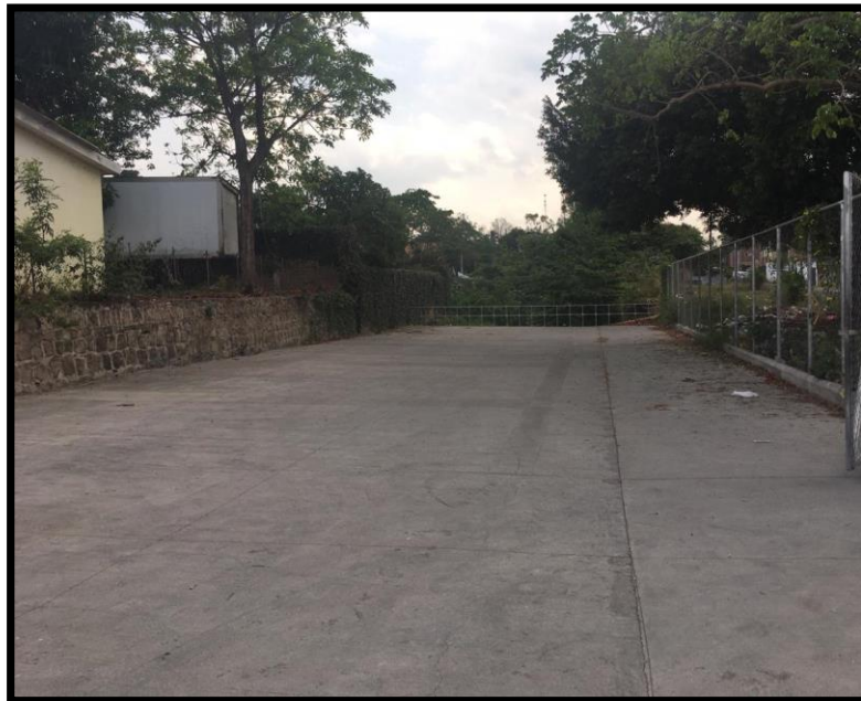
No. 2 Vista del estacionamiento existente, al fondo barandal a retirarse para formar un solo cuerpo con el nuevo proyecto.
