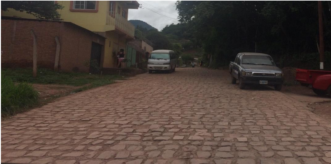
VISTA DEL TRAMO CON EMPEDRADO EXISTENTE
