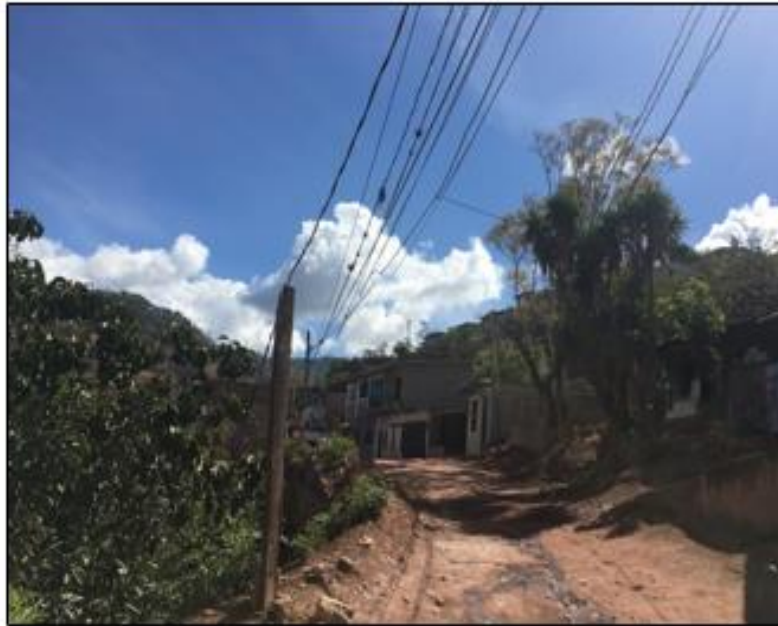
INICIO DE TRAMO A PAVIMENTAR CON CONCRETO HIDRÁULICO
