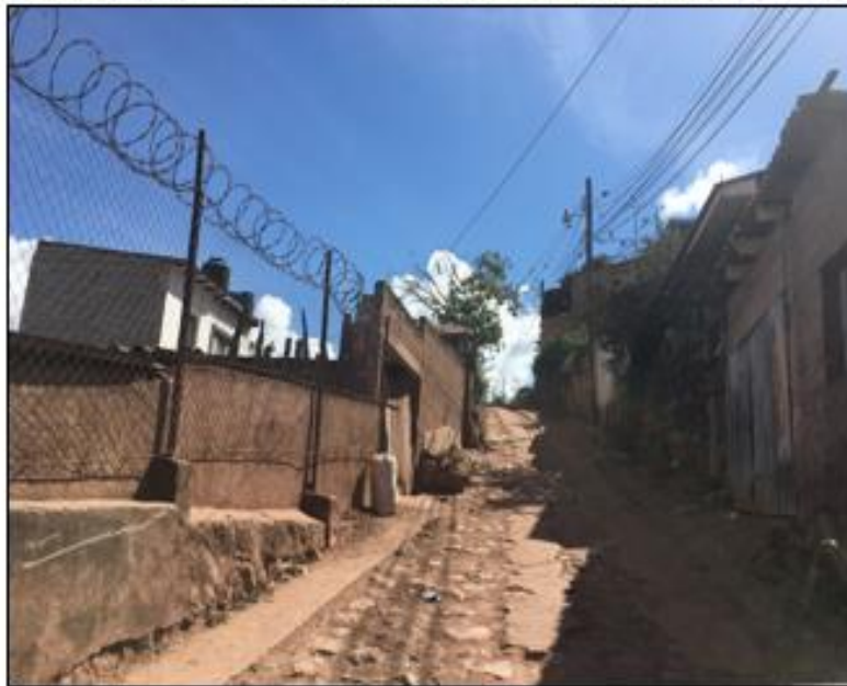
VISTA PANORÁMICA DE CALLE A PAVIMENTAR CON CONCRETO HIDRÁULICO
