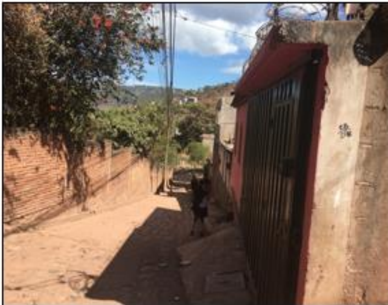
FINAL DE TRAMO A PAVIMENTAR CON CONCRETO HIDRÁULICO
