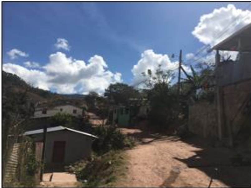
MURO DE CONTENCIÓN ( MAMPOSTERIA) 1
