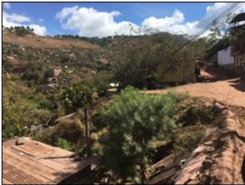
MURO DE CONTENCIÓN ( MAMPOSTERIA) 2
