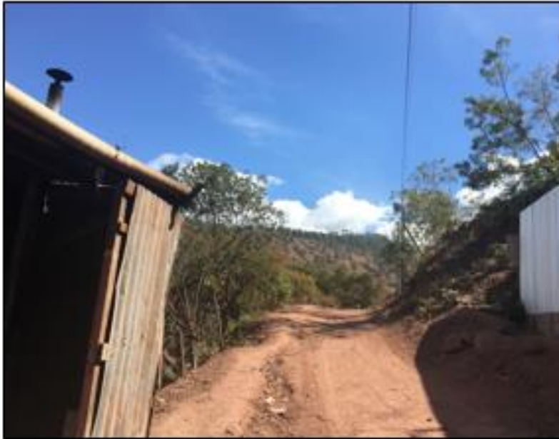
VISTA PANORÁMICA DE CALLE A PAVIMENTAR CON CONCRETO HIDRÁULICO
