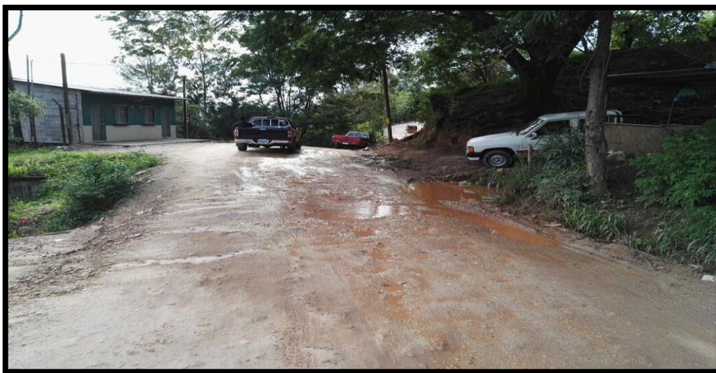
Tramo donde se construirán las huellas vehiculares
