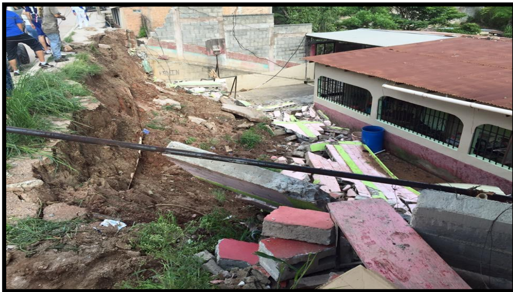
Vista del muro a Construir en Col. Los Pinos
