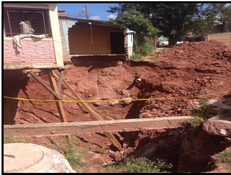
Panorama de la bóveda destruida a causa de las lluvias
