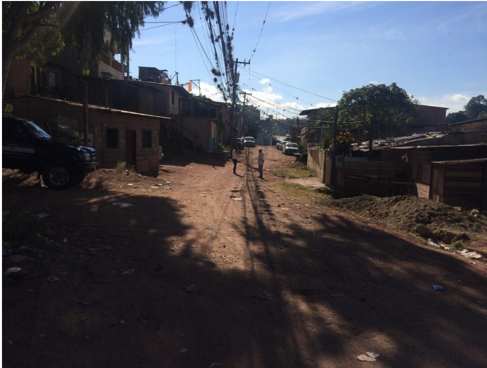
Foto No. 1: Inicio de calle "A"
