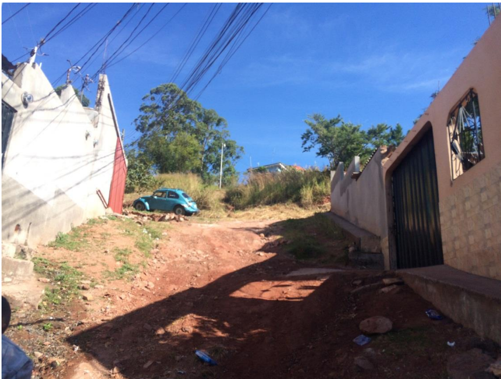
Foto No. 2: Estado actual de la calle "B"
