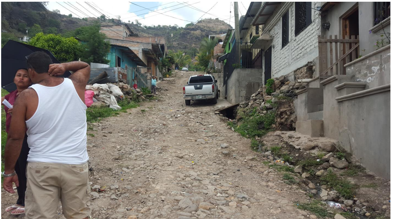
OTRA VISTA PANORAMICA DEL TRAMO A REPARAR
