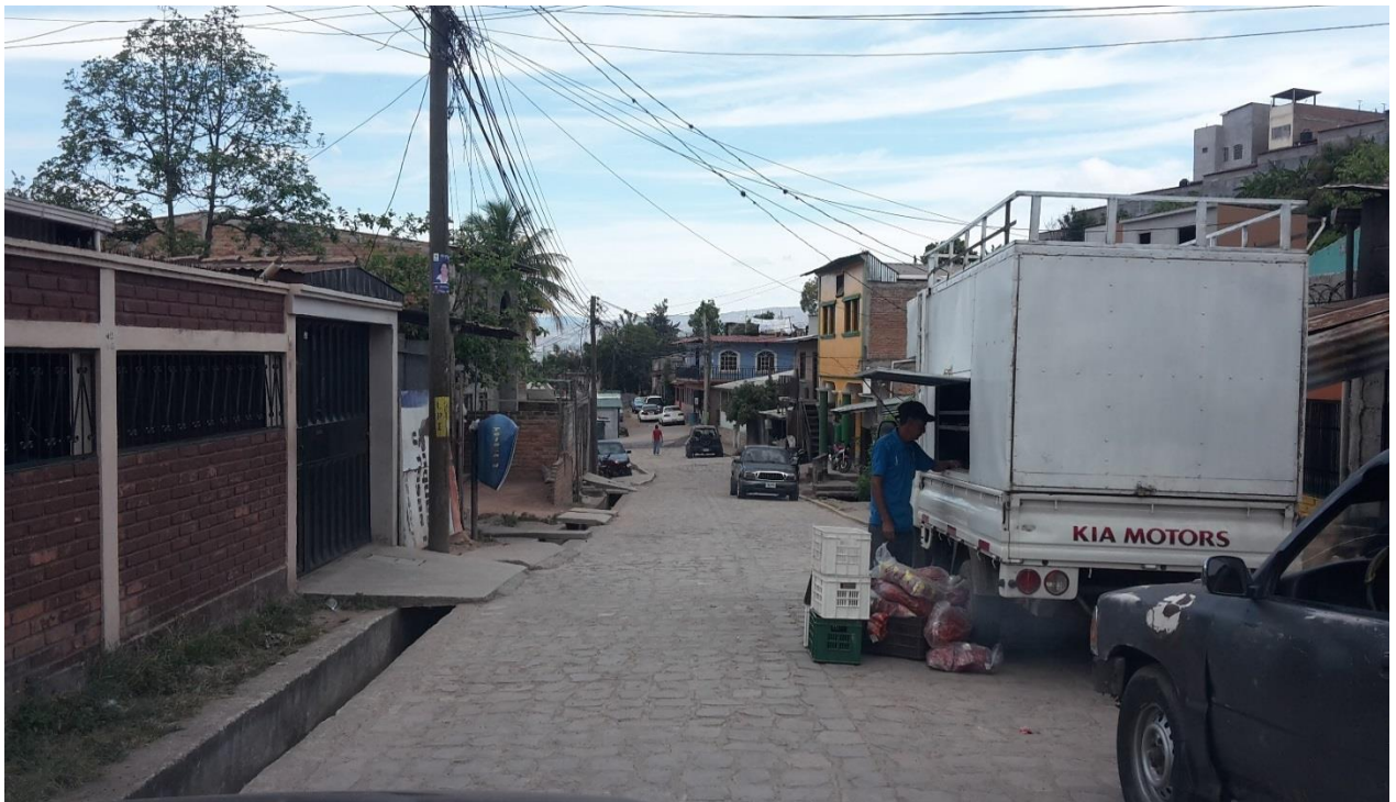
Foto No. 2: Estado actual del empedrado
