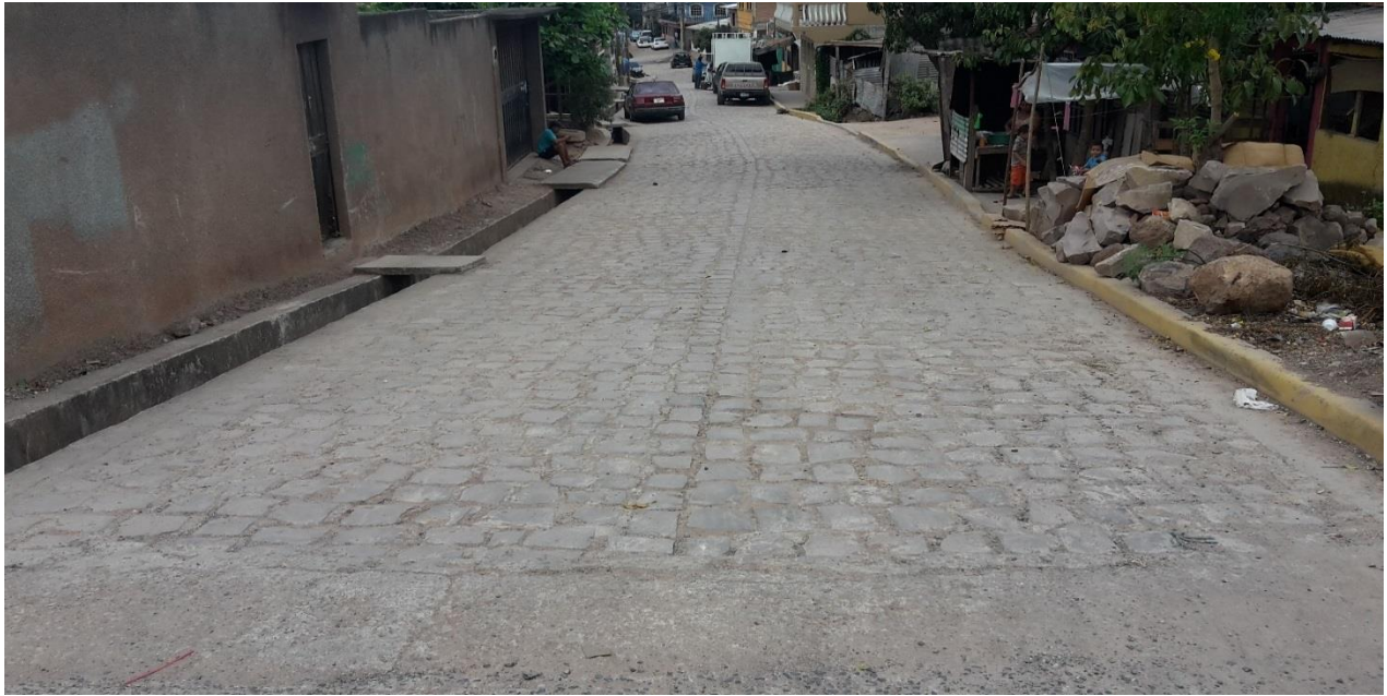
Foto No. 1: Inicio de calle "A"
