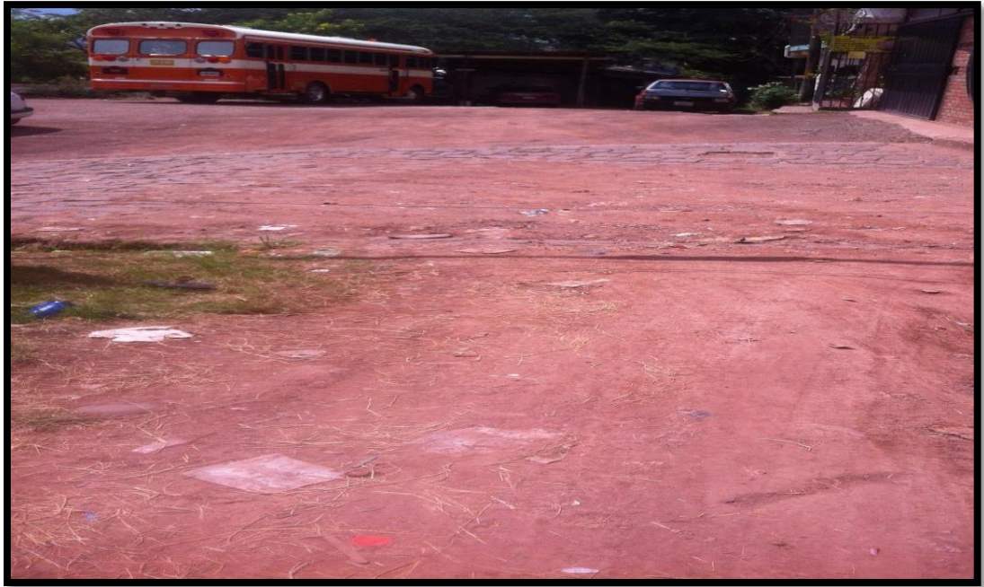
Foto 1. Inicio de tramo a pavimentar
