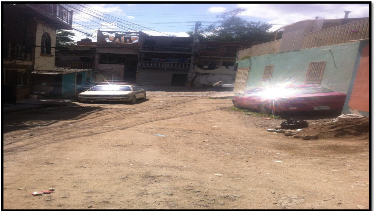
Final de calle a pavimentar
