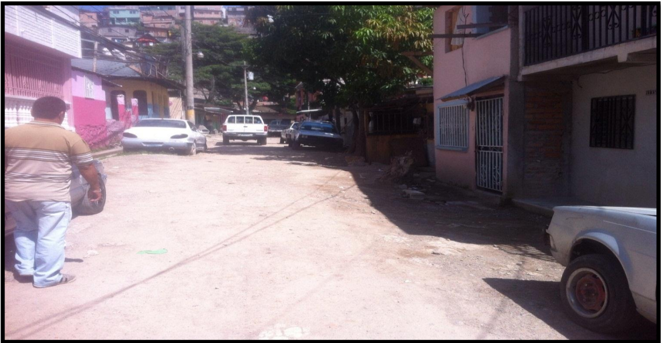
Vista panoramica de calle a pavimentar tramo 2
