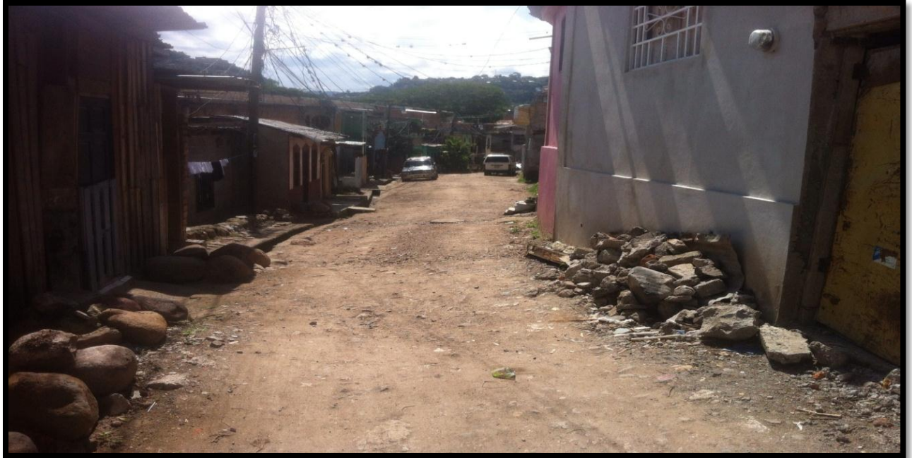
Tramo a pavimentar en col. Divanna
