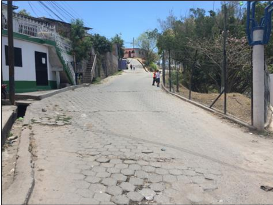
Inicio de la calle a pavimentar mostrando el adoquín
