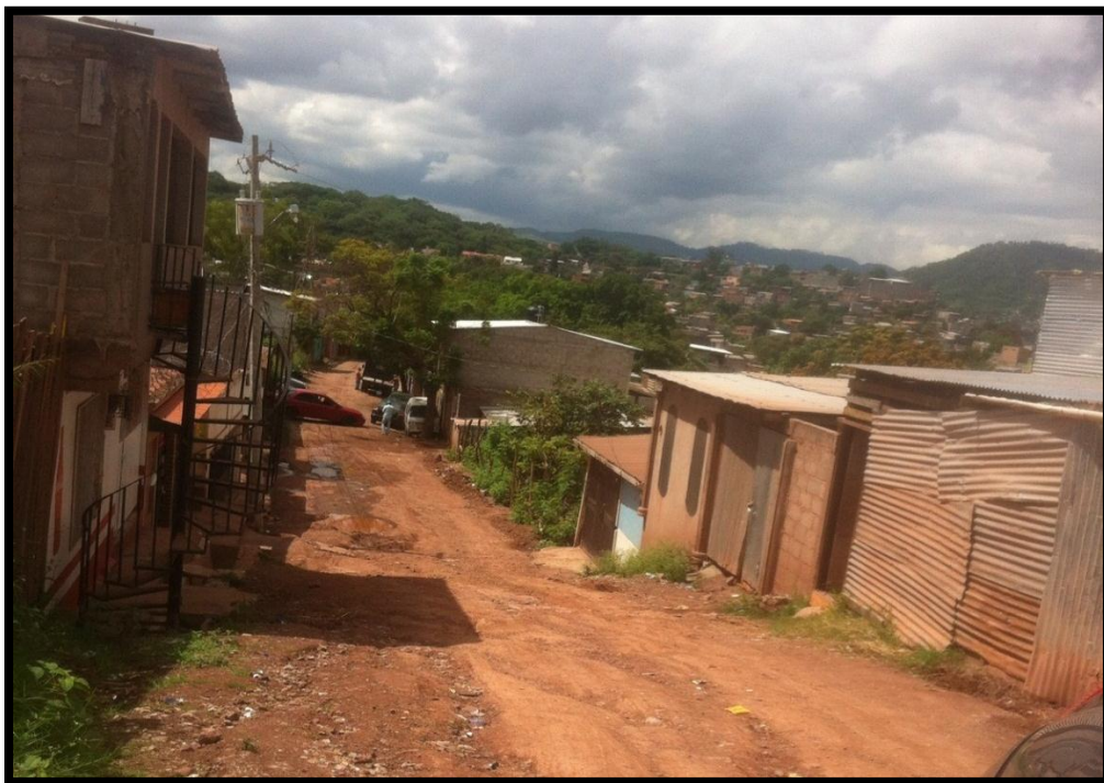
Foto 4. Final de la calle a pavimentar
