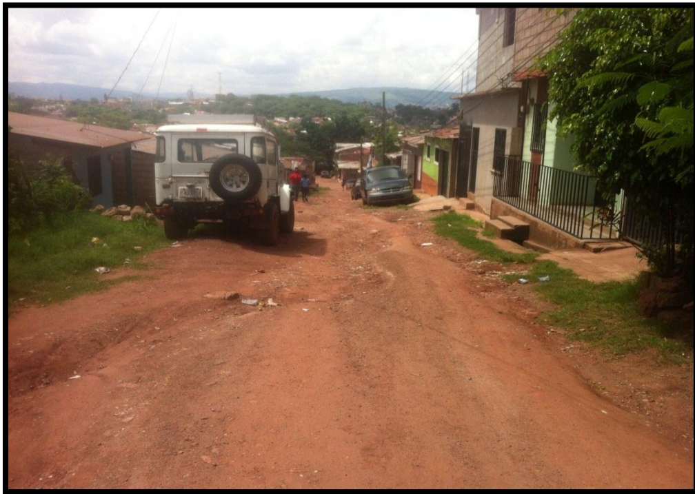
Foto 2. Se observa el mal estado de la calle
