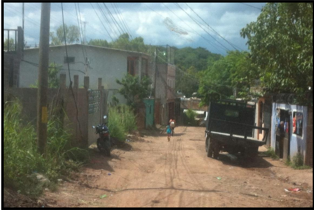
Foto 1. Inicio tramo a pavimentar
