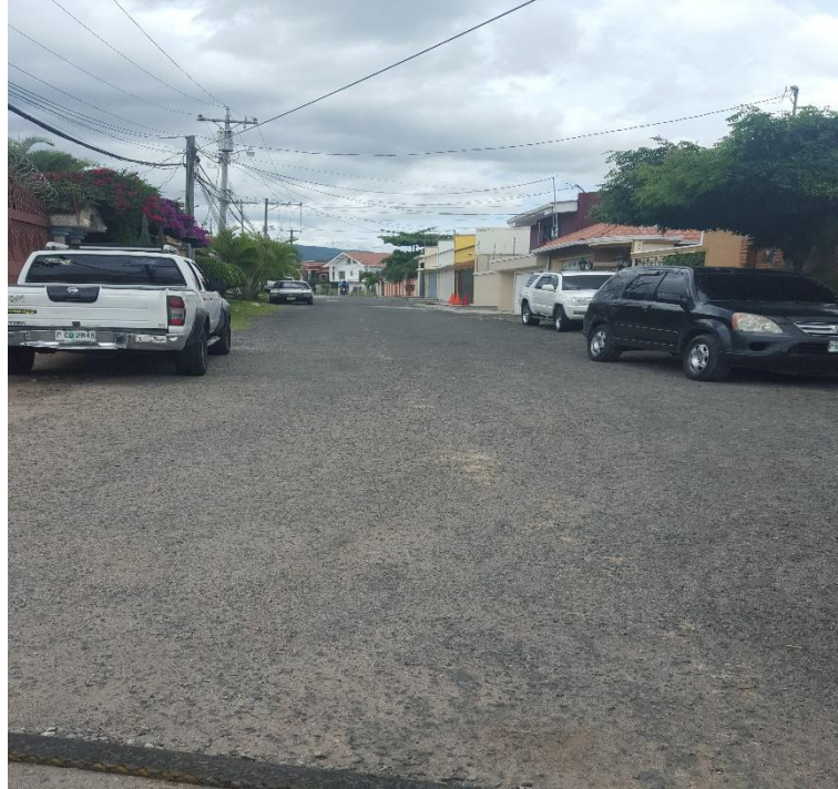
VISTA PANORÁMICA DEL TRAMO
