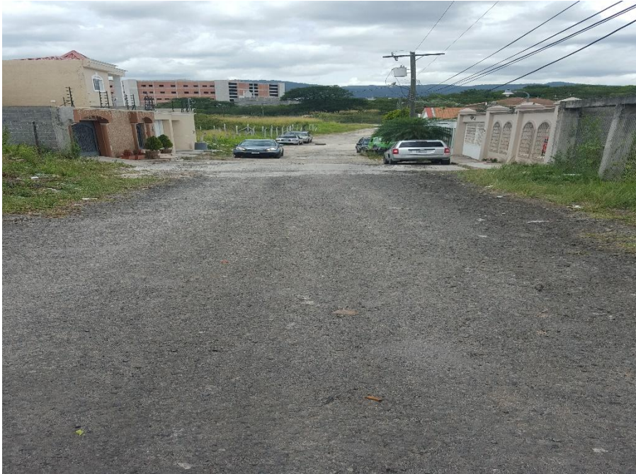
VISTA DEL FINAL DEL TRAMO A REPARAR
