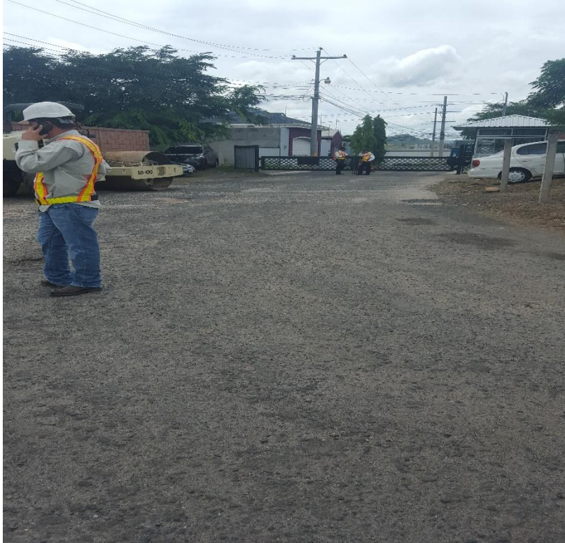
INICIO DE TRAMO CON WHITE TOPPING
