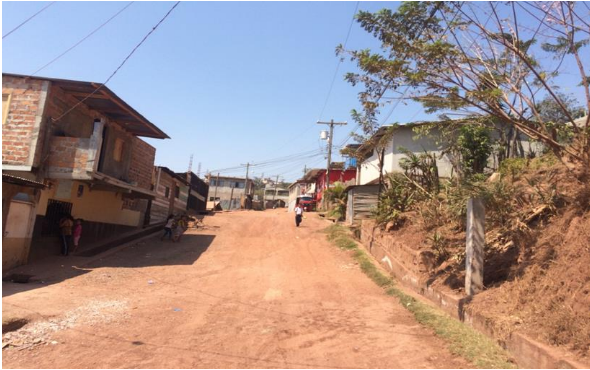
En la imagen se muestra tramo de inicio de la calle a pavimentar
