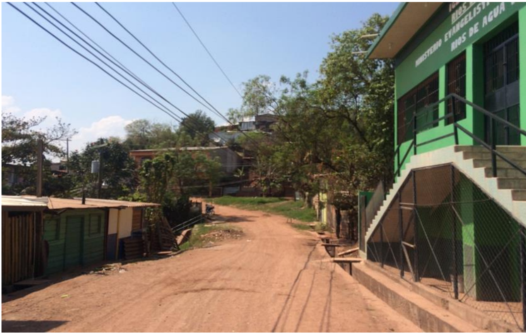
Tramo a pavimentar frente a iglesia en colonia Guillen
