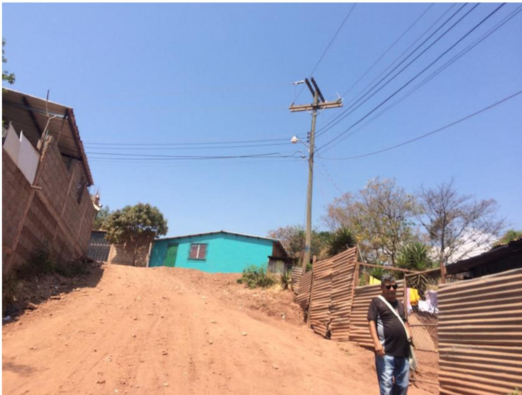
Vista de tramo final de calle a pavimentar
