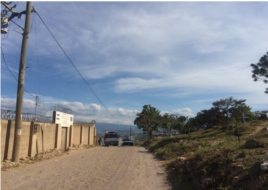
Foto No. 4: Final de calle a pavimentar
