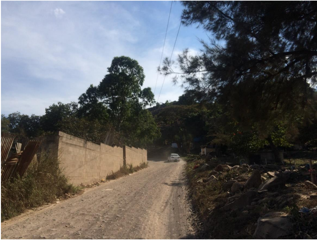
Foto No. 3: Vista de calle a pavimentar
