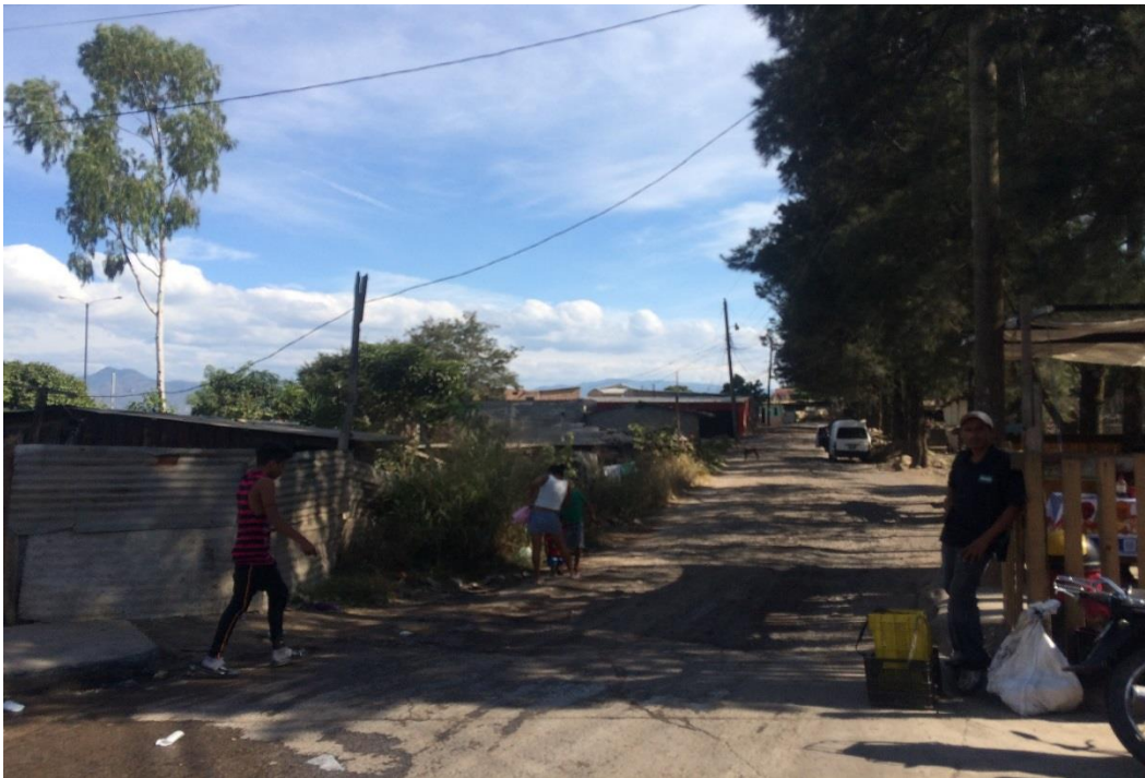
Foto No. 1: Inicio de calle a pavimentar
