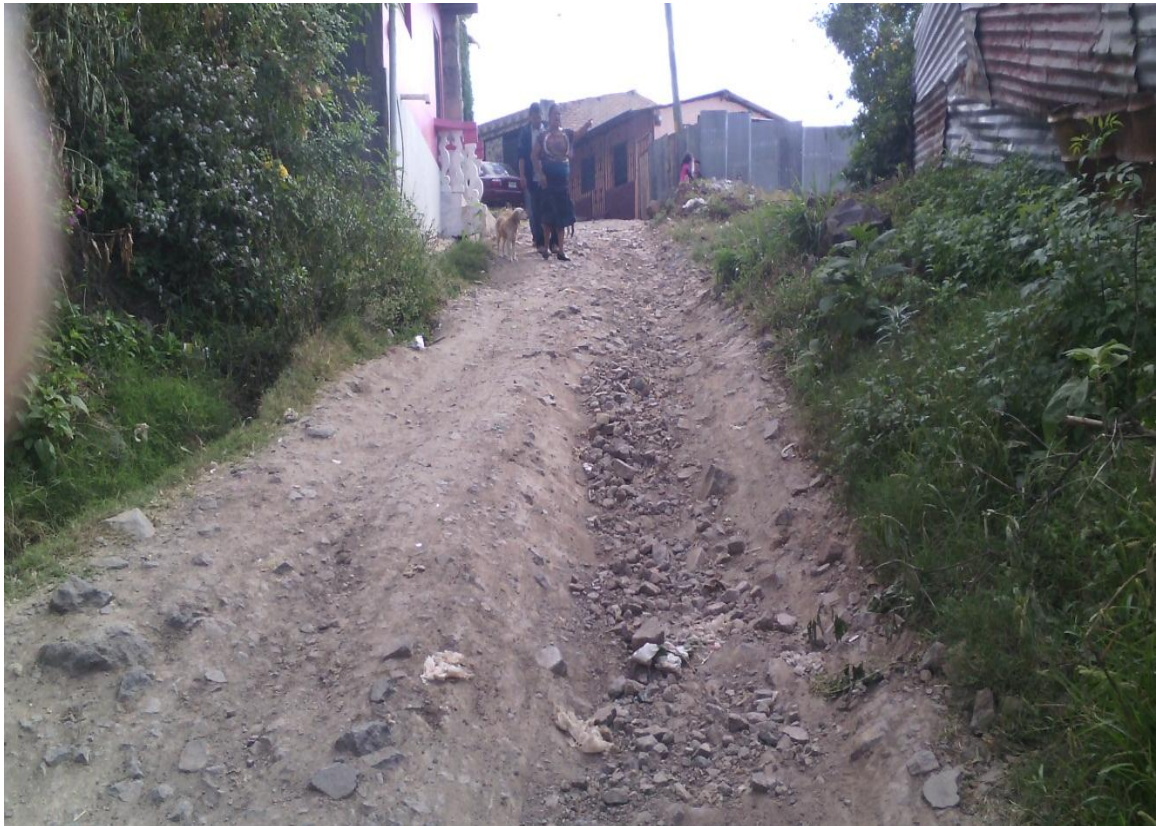
Final de calle a pavimentar
