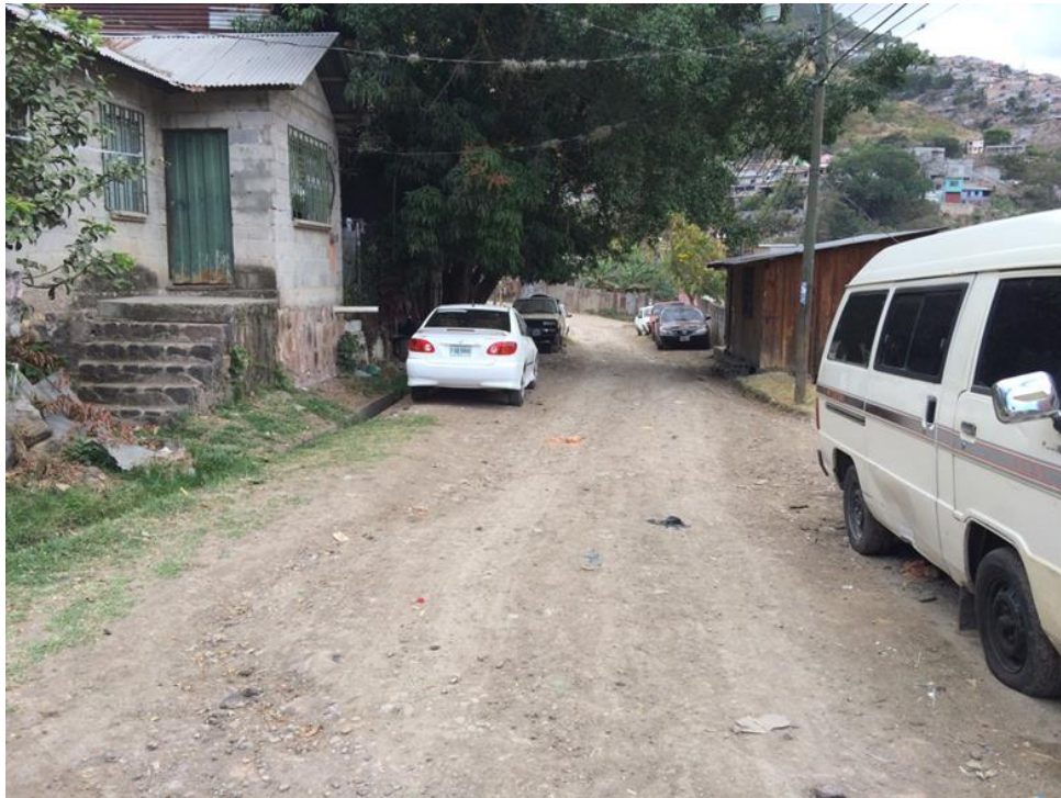
CONDICIONES ACTUALES DE OTRO SECTOR DE LA CALLE A PAVIMENTAR
