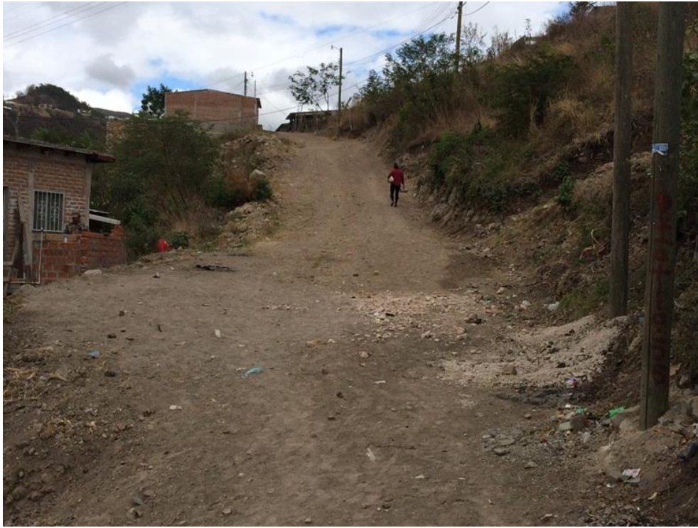
VISTA DE LAS ACTUALES CONDICIONES EN QUE ENCUENTRA OTRO TRAMO DE LA CALLE A PAVIMENTAR
