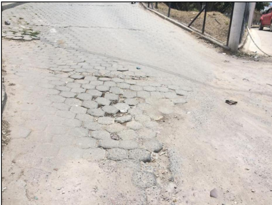
**Foto 2.** Tramo con adoquín dañado.
