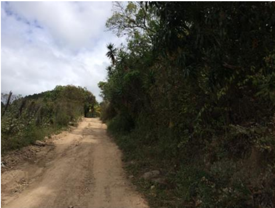
VISTA ACTUAL DE CALLE A REPARAR
