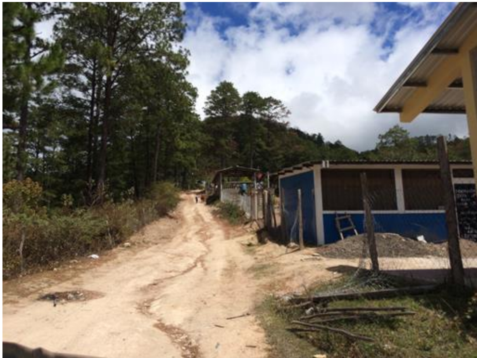
VISTA DEL FINAL DEL BALASTADO
