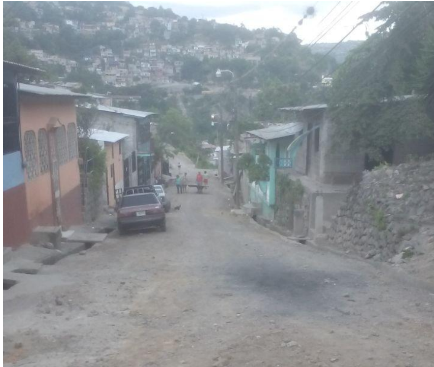
VISTA PANORÁMICA DE TRAMO A PAVIMENTAR
