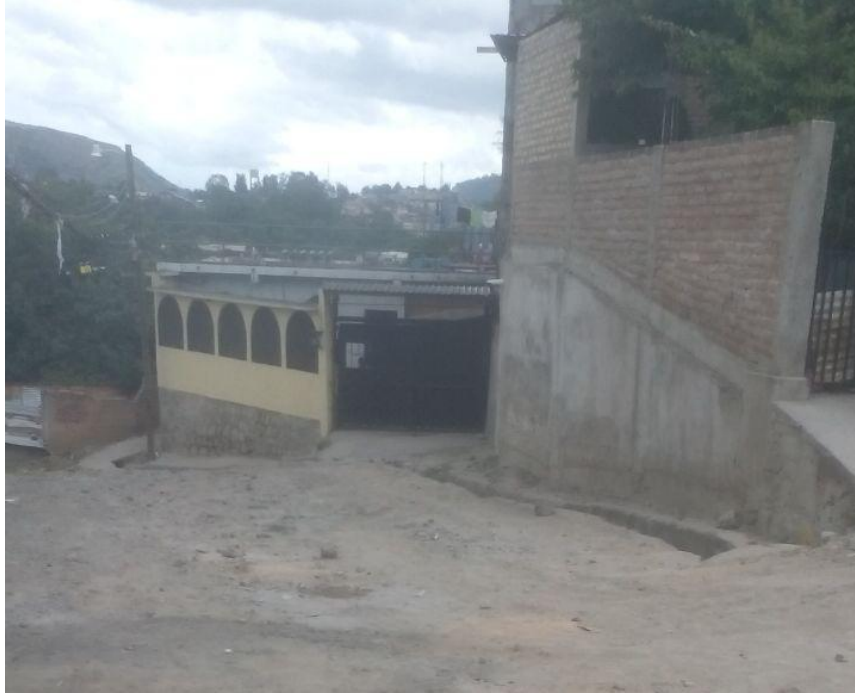
VISTA PANORAMICA DEL INICIO DEL PROYECTO
