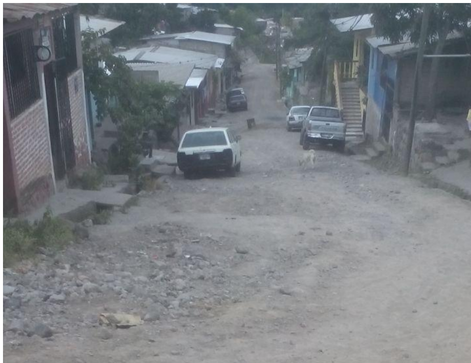
VISTA PANORÁMICA DE TRAMO A PAVIMENTAR
