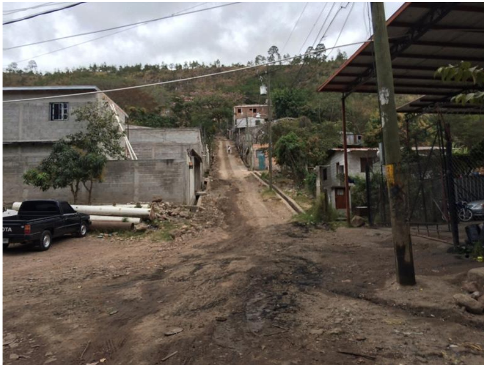
PANORAMA DE LA CALLE A PAVIMENTAR
