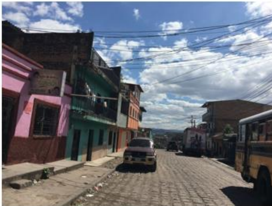
VISTA GENERAL DE CONDICIONES ACTUALES DE EMPEDRADO
