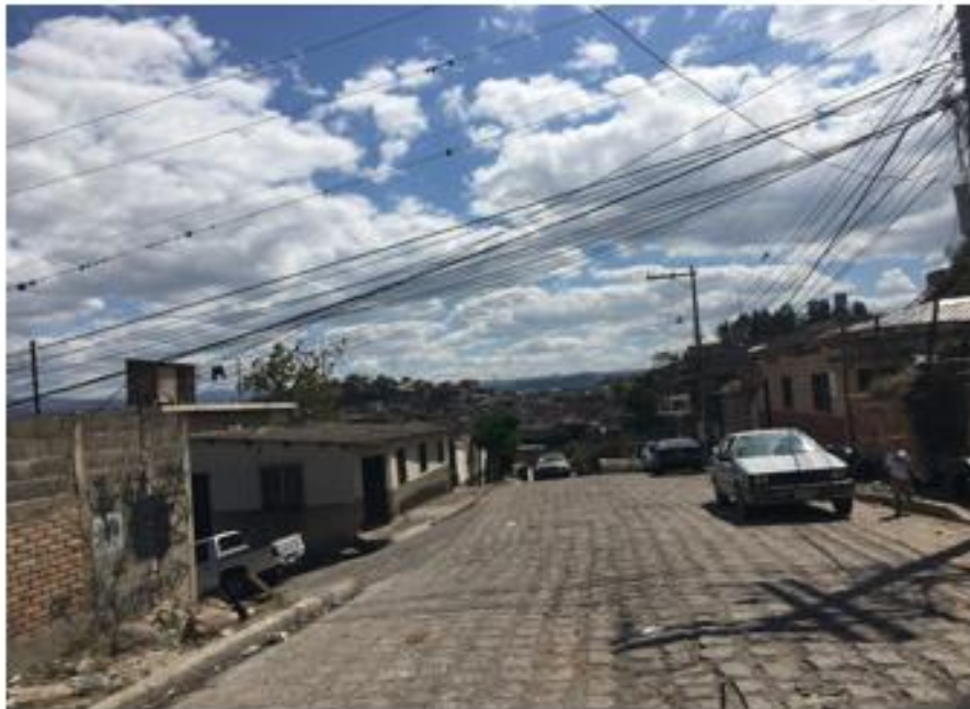
VISTA DE OTRO SECTOR DEL EMPEDRADO A CUBRIR CON WHITE TOPPING
