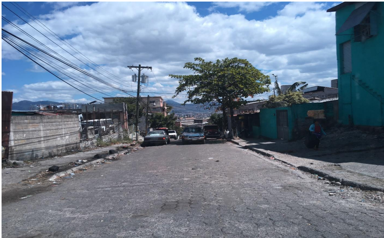
VISTA DE LA CALLE A PAVIMENTAR CON CONCRETO HIDRÁULICO
