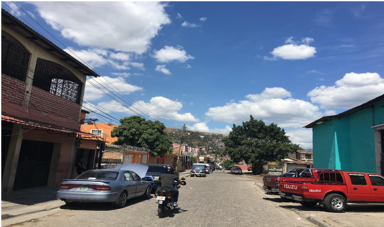
INICIO DE CALLE A PAVIMENTAR
