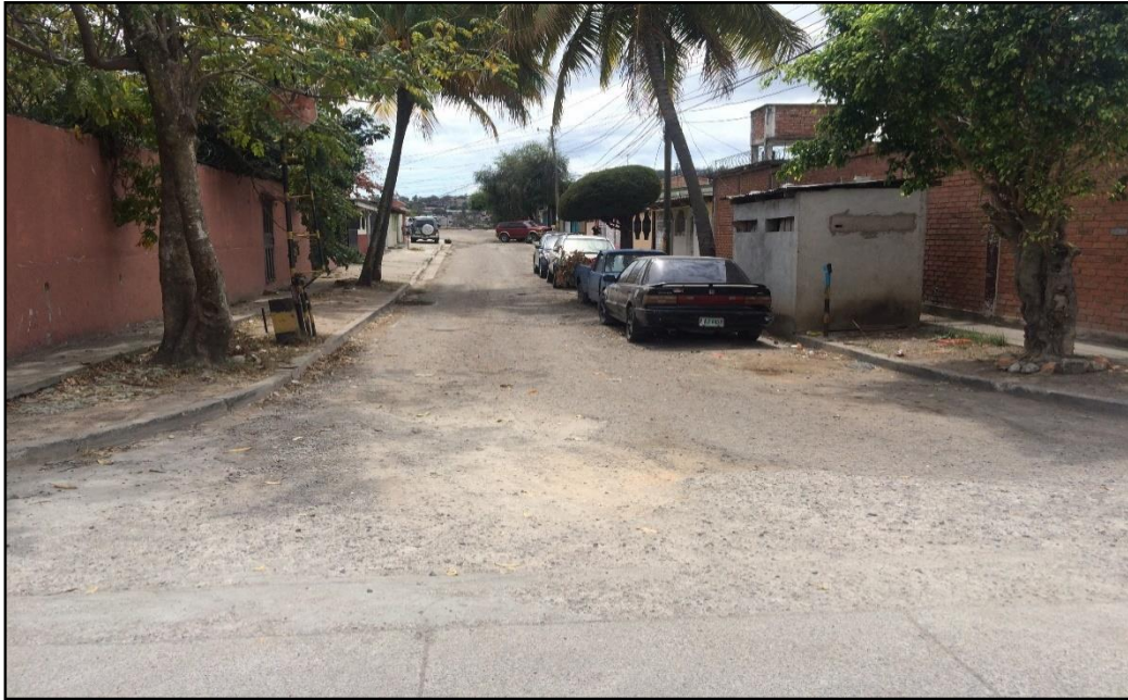
Vista panorámica del tramo 4 a pavimentar
