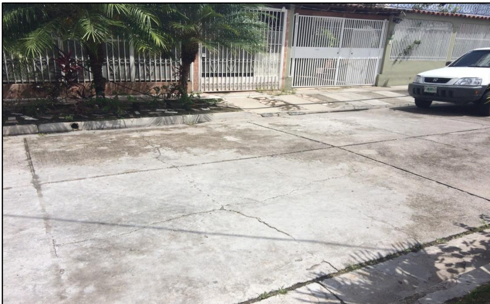
Vista donde se realizará el corte y sellado de juntas
