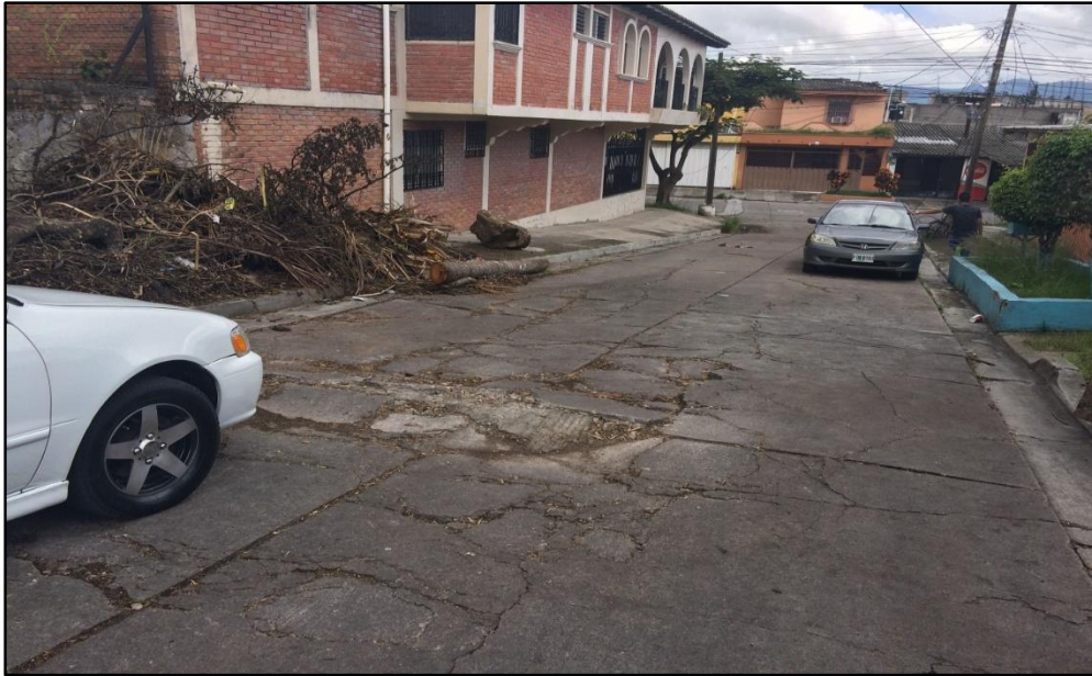
Inicio de tramo 1 a pavimentar
