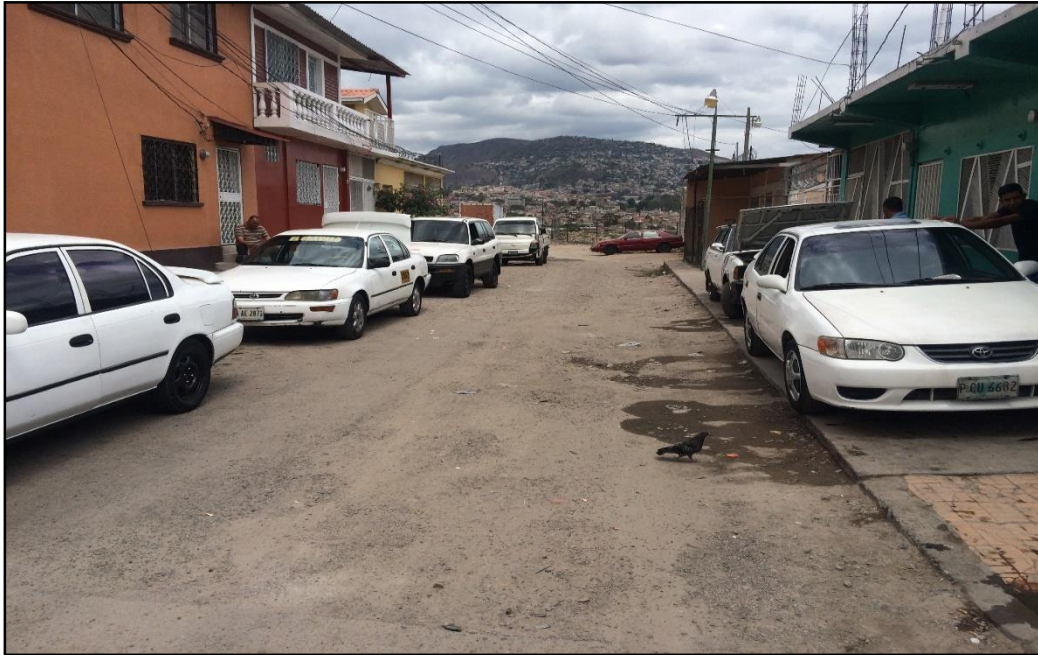
Vista panorámica del tramo 2 a pavimentar
