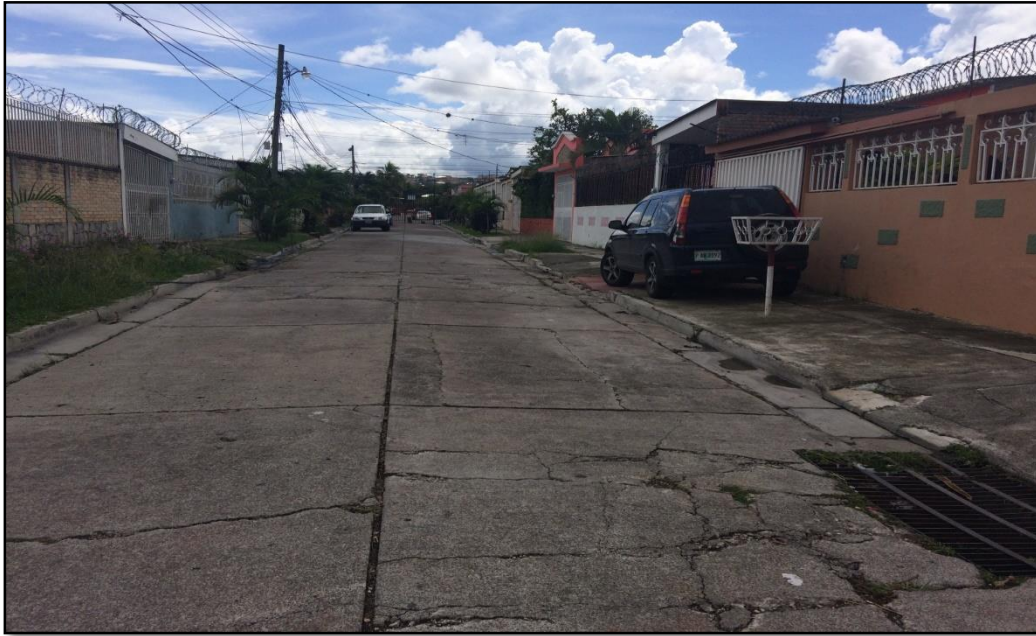
Vista panorámica del tramo donde se realizará el corte y sellado de juntas
