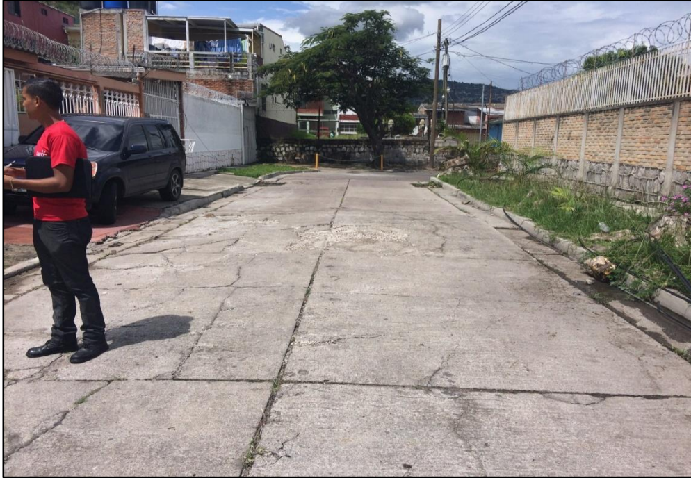
Final del tramo 1 a pavimentar
