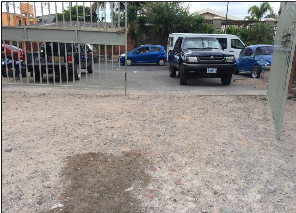
Inicio de Tramo 2 a pavimentar
