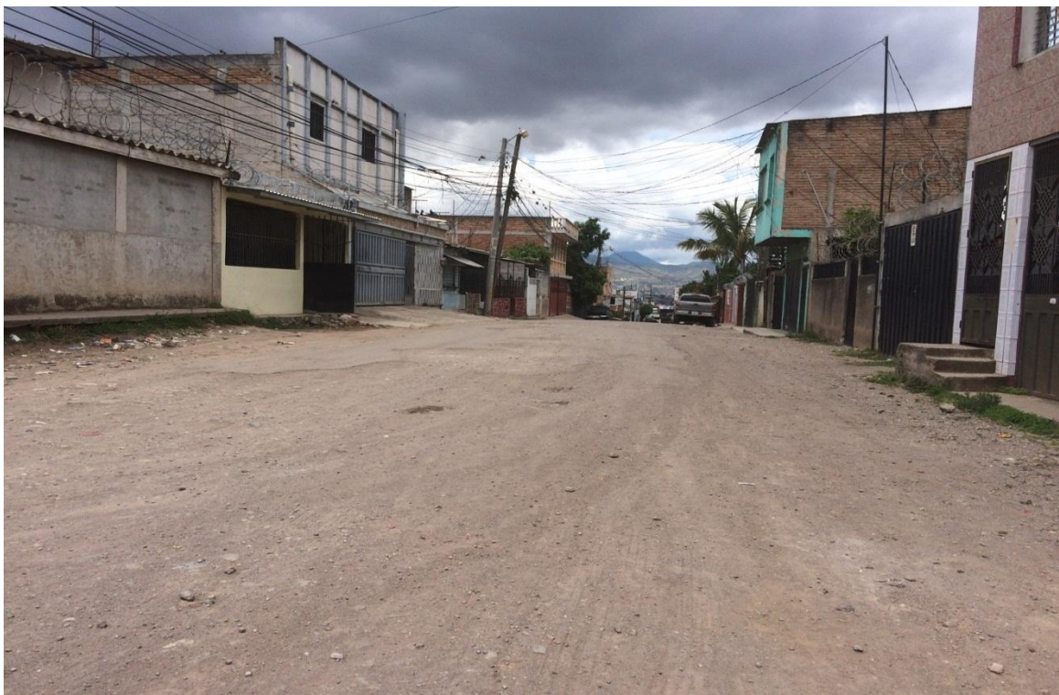
Vista de la calle a pavimentar
