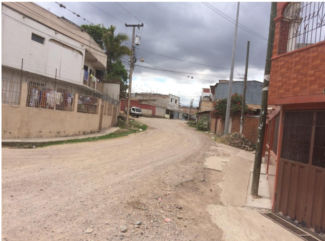
Vista panorámica de la calle a pavimentar
