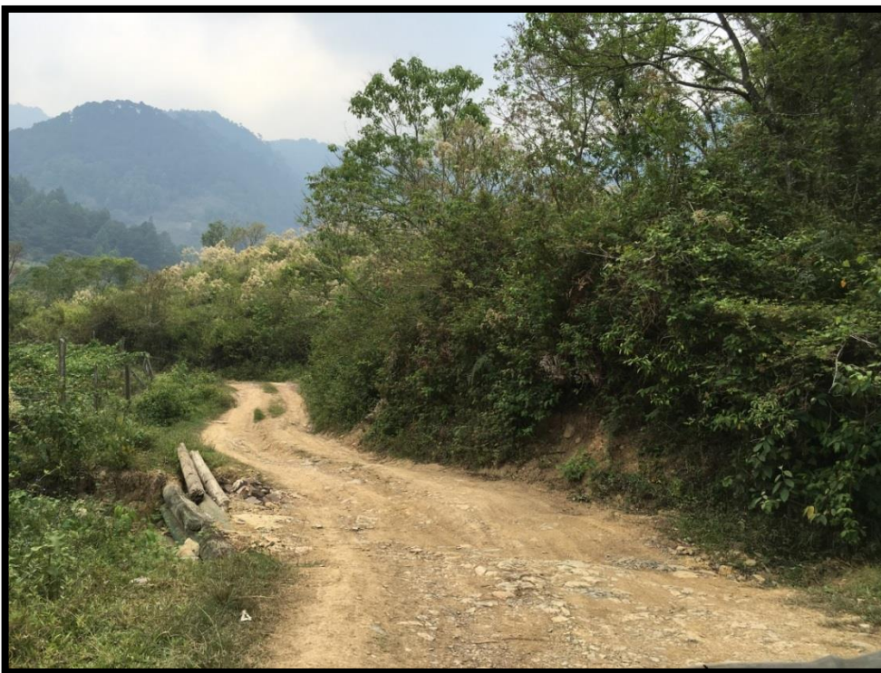
Vista de las Calles donde se instalará alcantarilla
