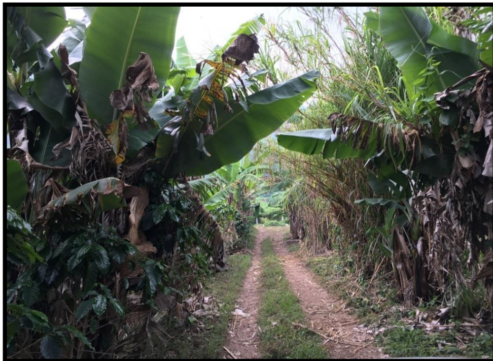
Vista del Sitio tramo final a mecanizar y balastar
