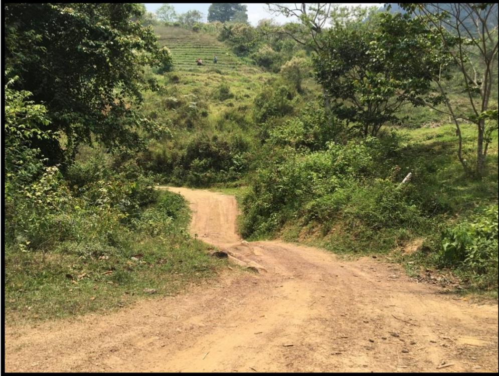
Vista de la Calle donde se construirán caja puente
