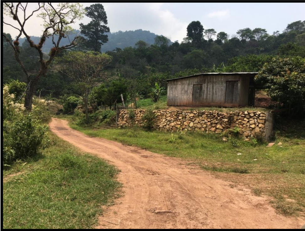
Vista del Sitio tramo a mecanizar y balastar
