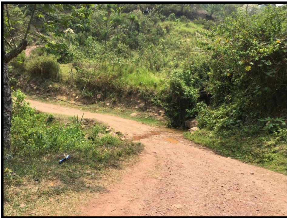
Vista de las Calles donde se instalara alcantarilla
