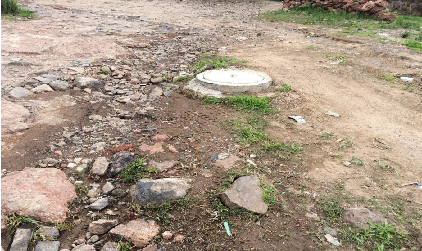
CALLE A PAVIMENTAR COL. CERRO GRANDE ZONA II
