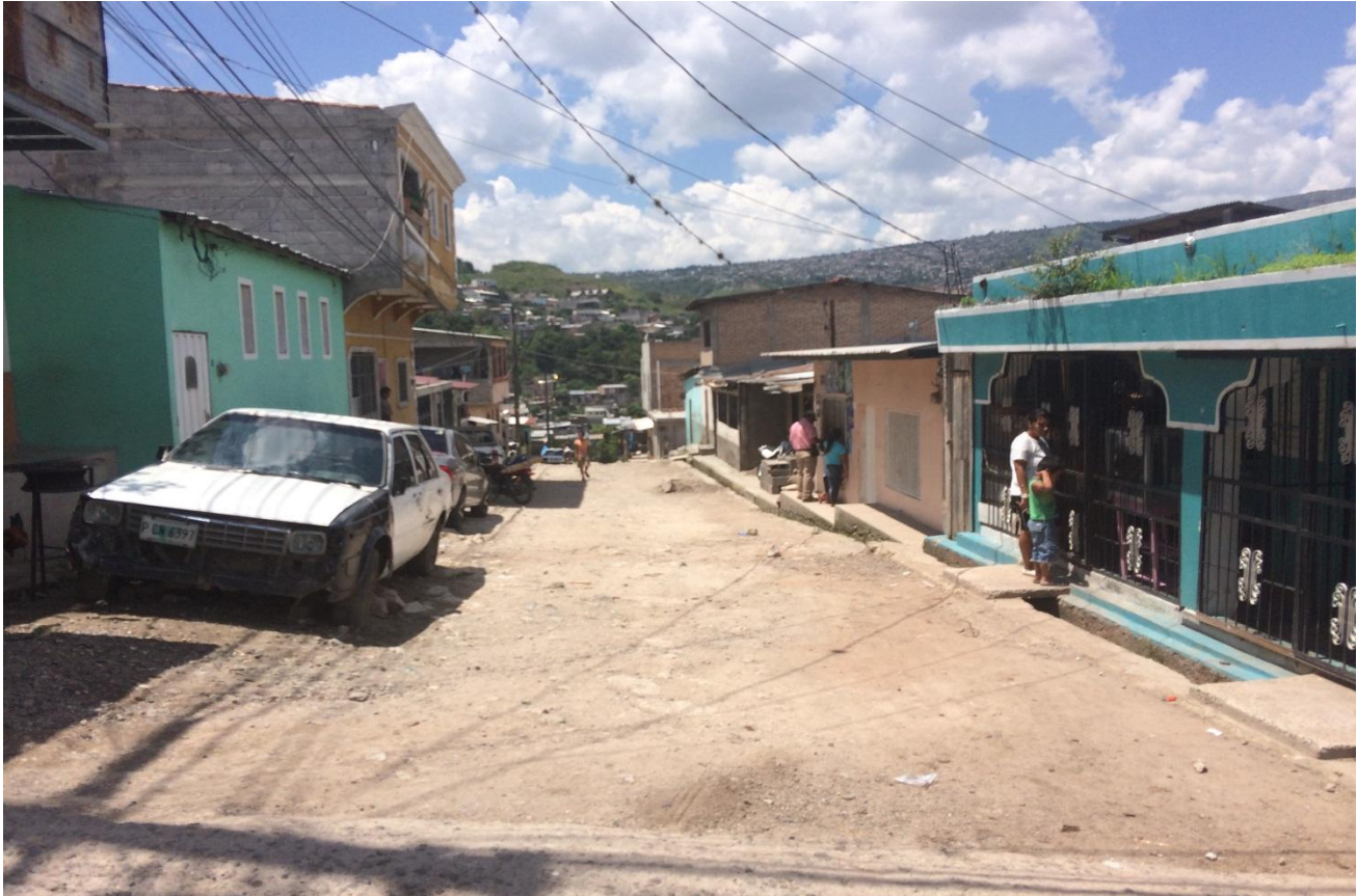
INICIO DE PROYECTO DE PAVIMENTACION
