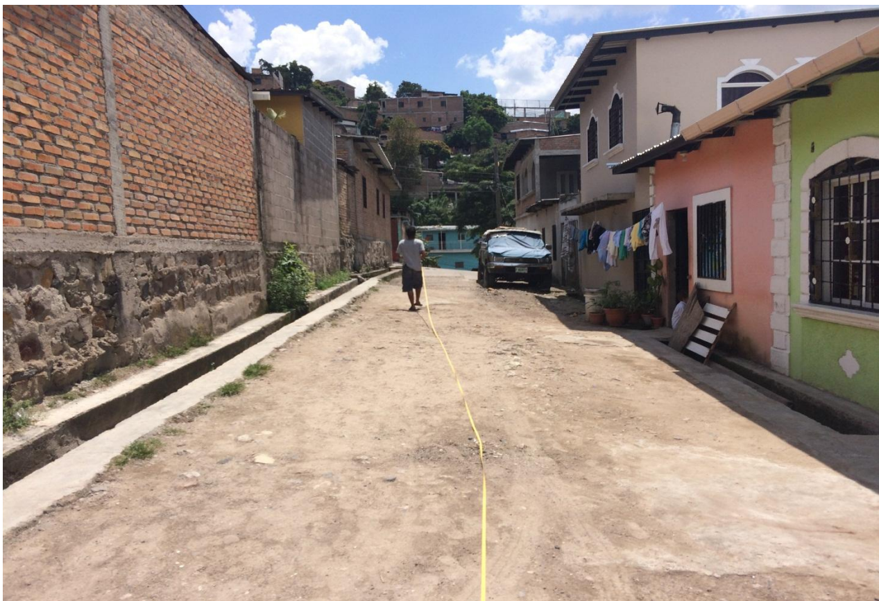
VISTA PANORAMICA DE CALLE A PAVIMENTAR
