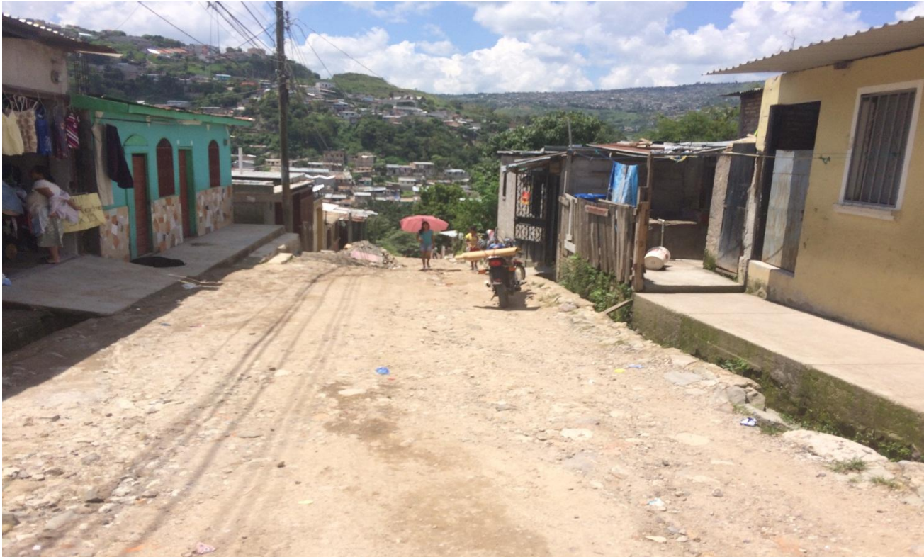
TRAMO DE CALLE A PAVIMENTAR
