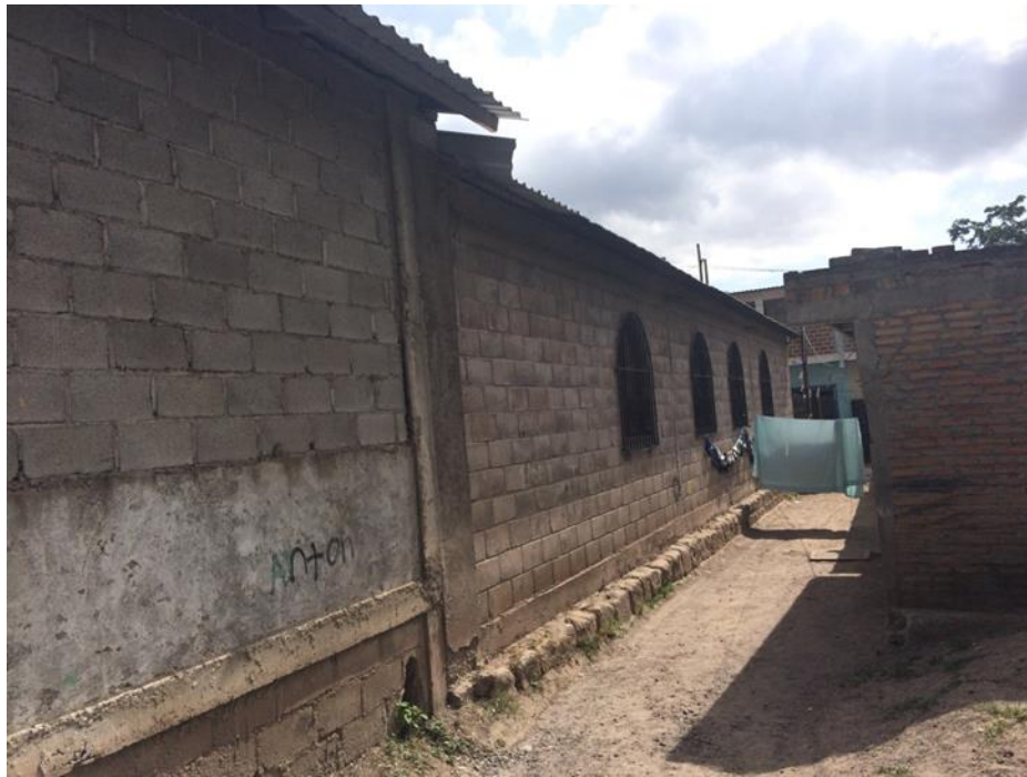
VISTA EN DONDE SE INSTALARÁ EL CANAL PARA AGUA LLUVIA
