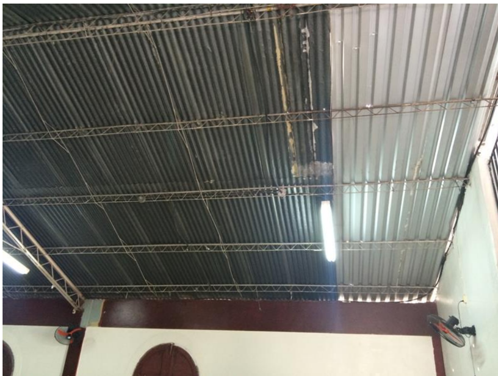
LÁMINAS DE ZINC A DESMONTAR
