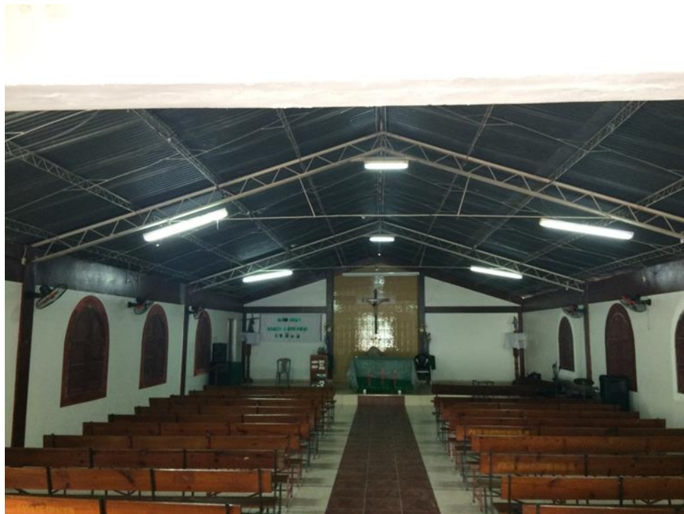
VISTA EN DONDE SE INSTALARÁ EL CIELO FALSO
