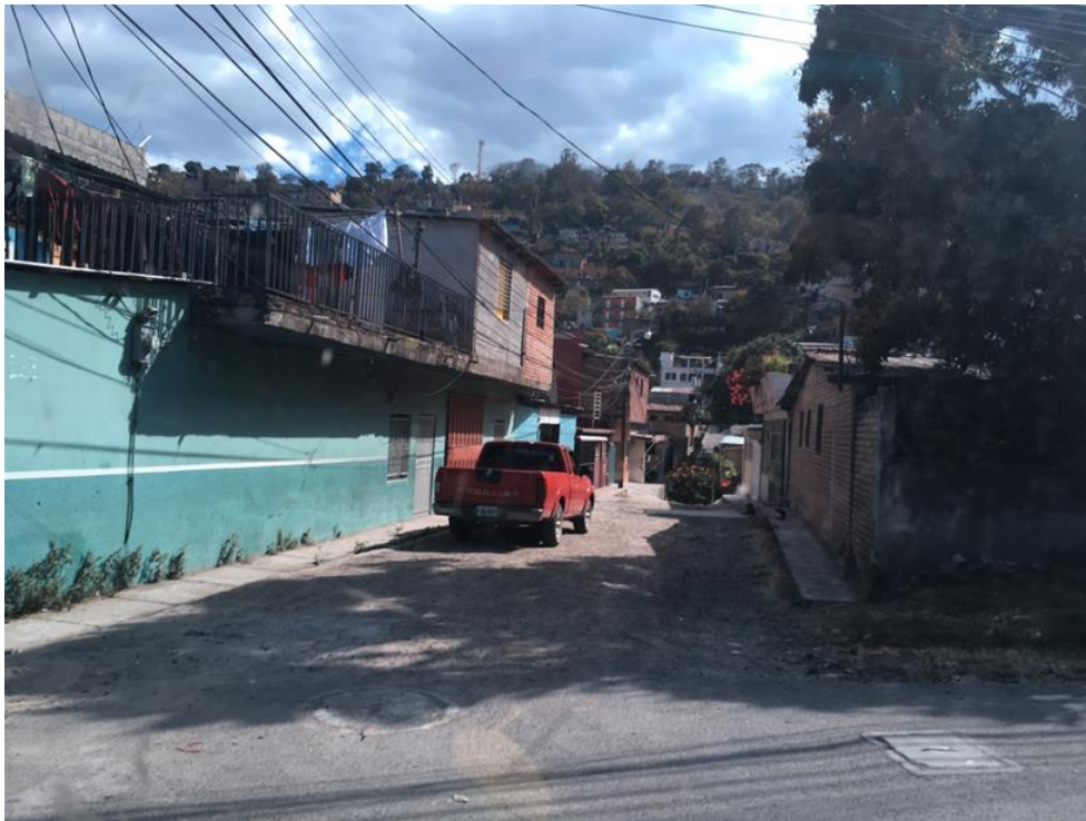
PANORAMA DE LA CALLE A PAVIMENTAR
