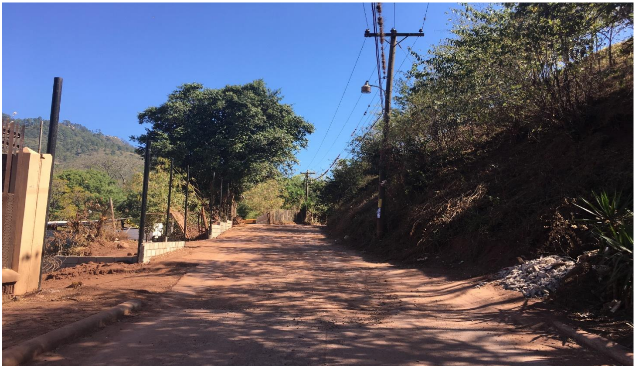
FINAL DE CALLE DONDE SE CONSTRUIRÁN LAS HUELLAS
