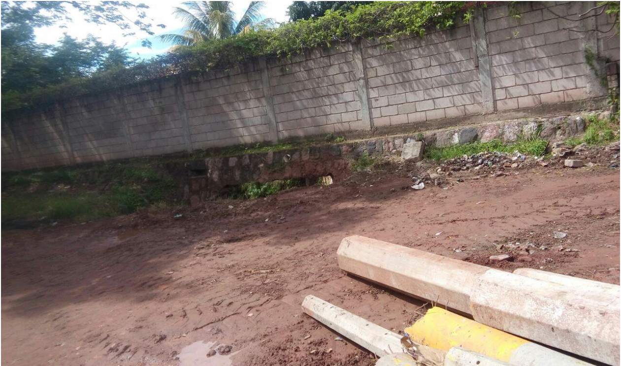
PANORÁMA DONDE SE CONSTRUIRÁ EL MURO
