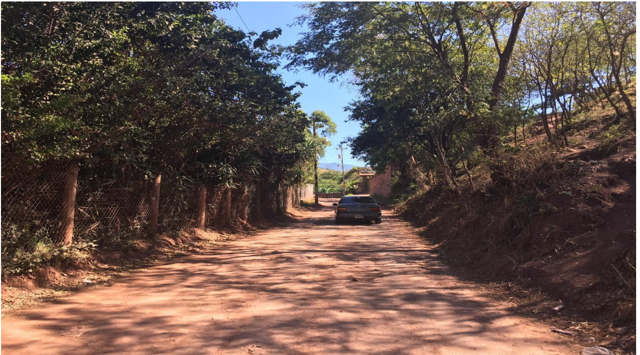
PANORÁMA DE CALLE A REPARAR
