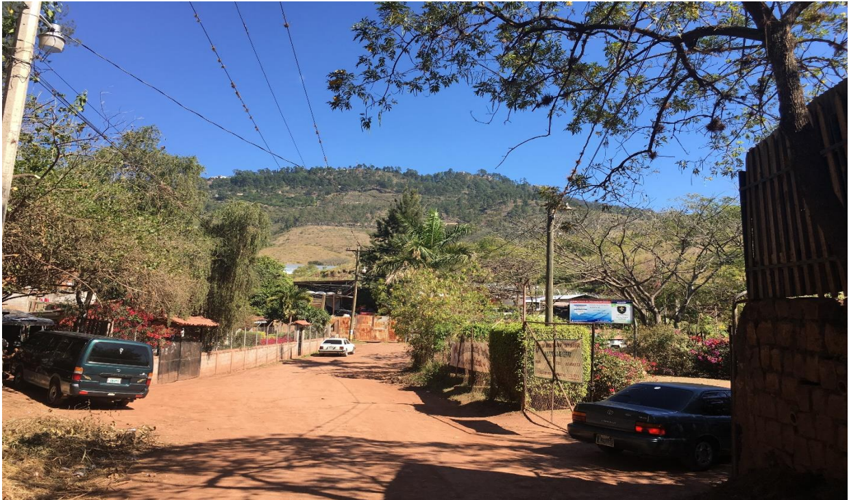
SE OBSERVA EL MAL ESTADO DE LA CALLE
