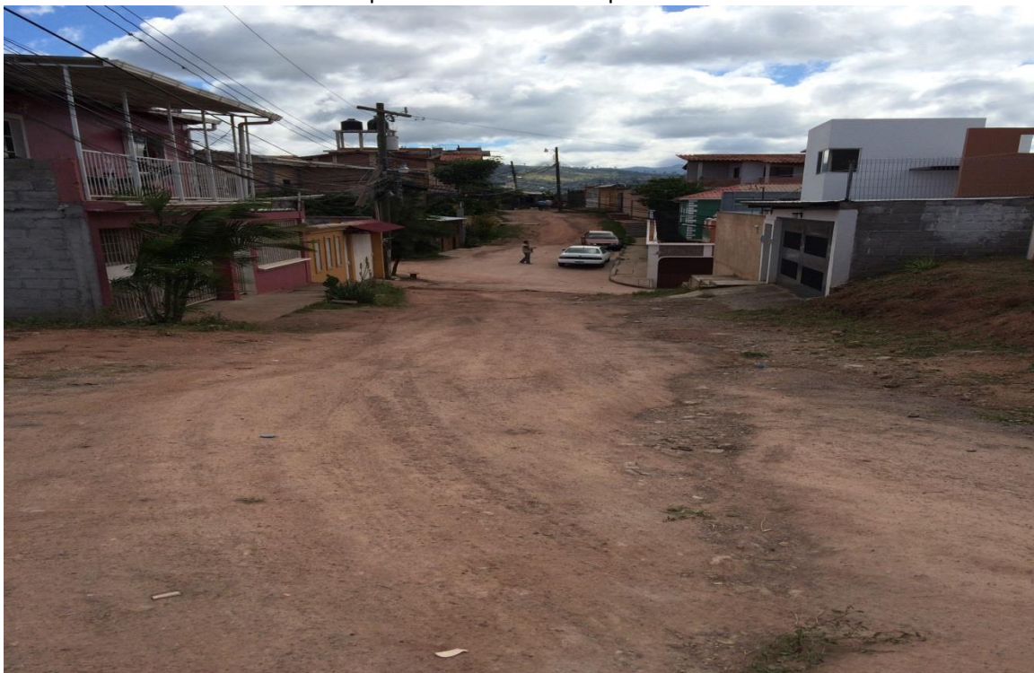
Final de calle a pavimentar
