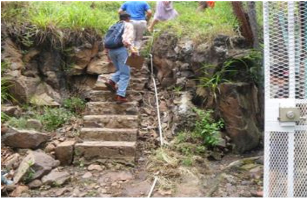
Ilustración 1: Condiciones de las vías de tránsito en la zona
