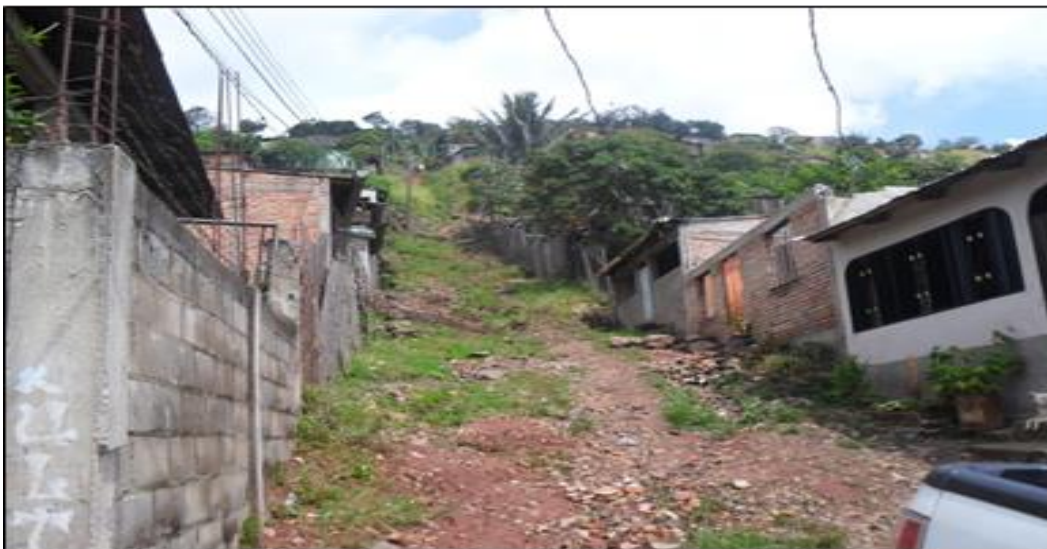
Ilustración 1: Acceso vehicular sin drenaje de la colonia en el sector 7
