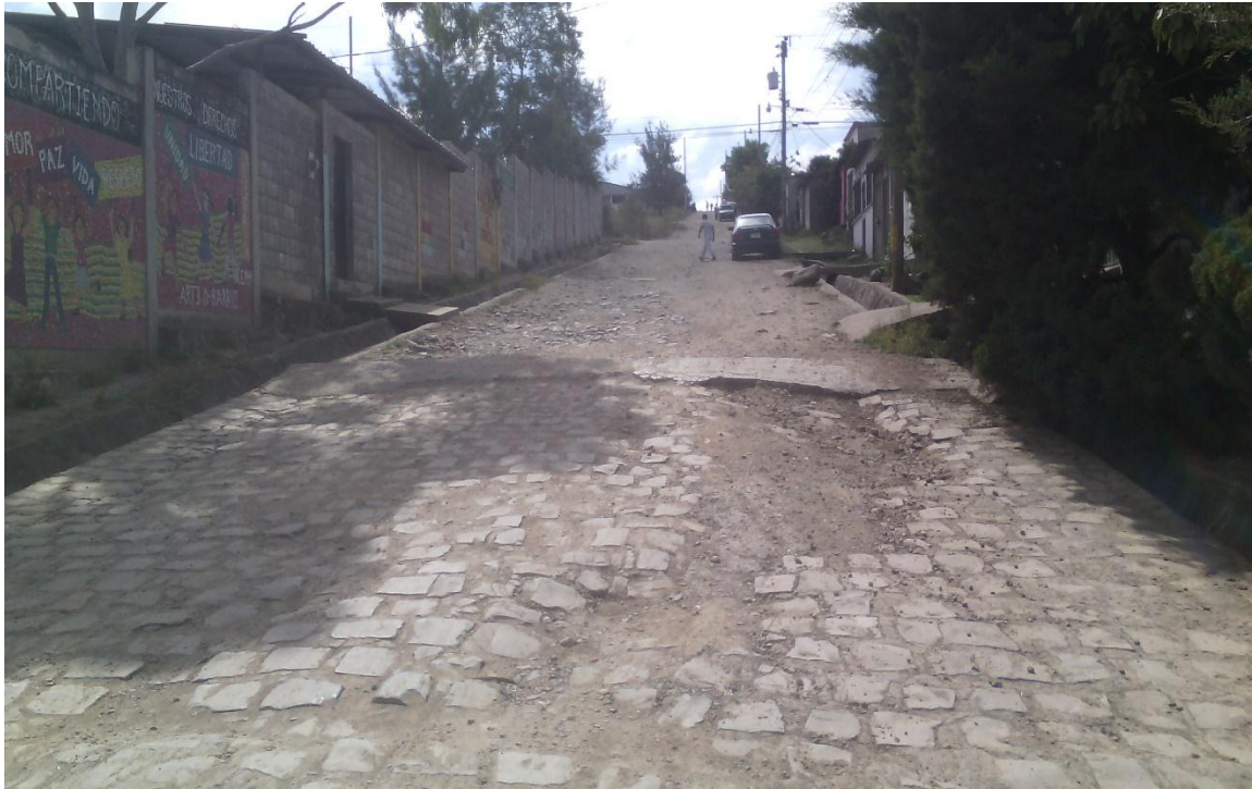
Vista panorámica de tramo a pavimentar
