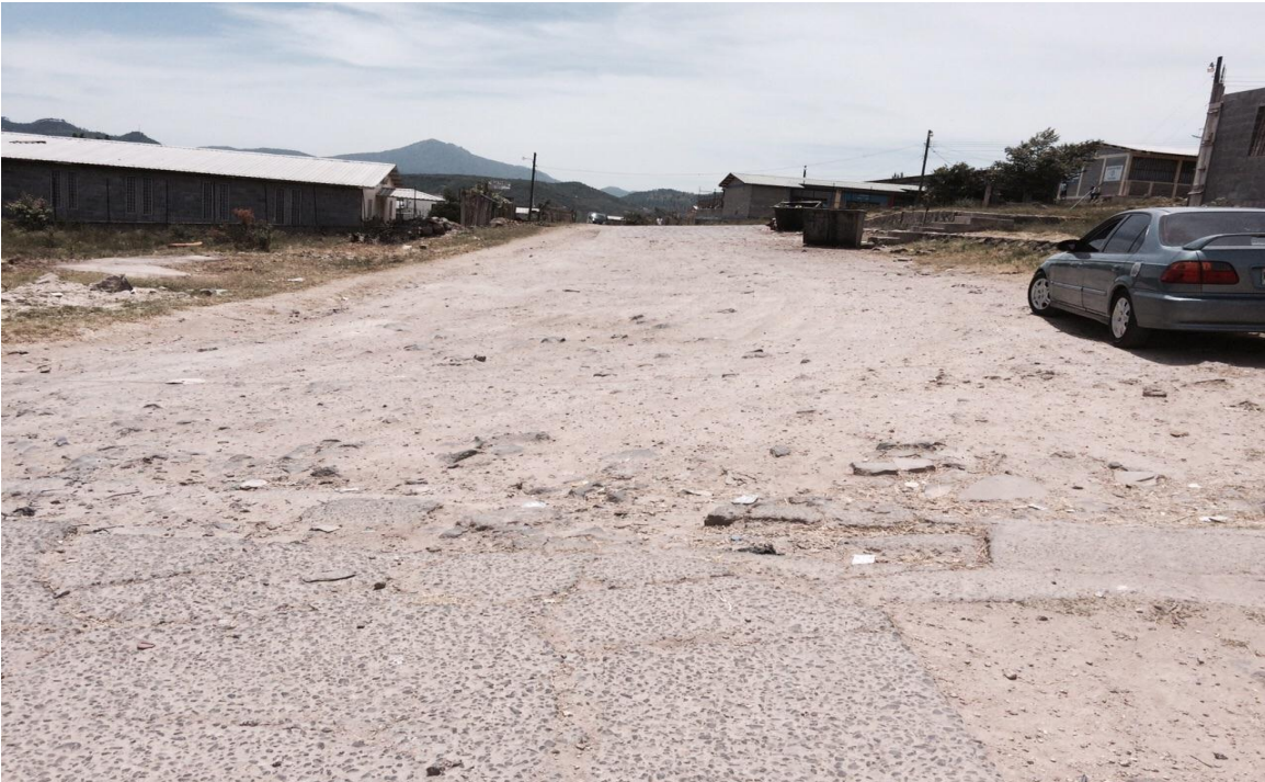
Inicio de donde se hará la pavimentación
