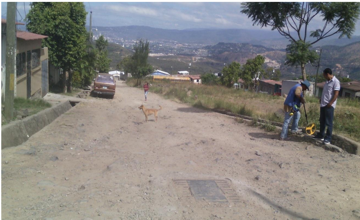
Final del tramo a pavimentar
