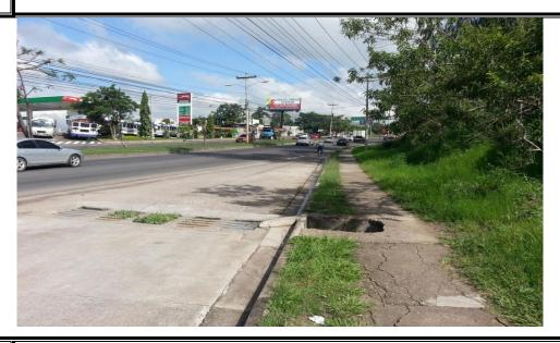
En el tramo existe un quiebre de pata que debe ser rehabilitado para que se pueda No. 2 evacuar el agua de la calzada, al igual que las cunetas y aceras.
