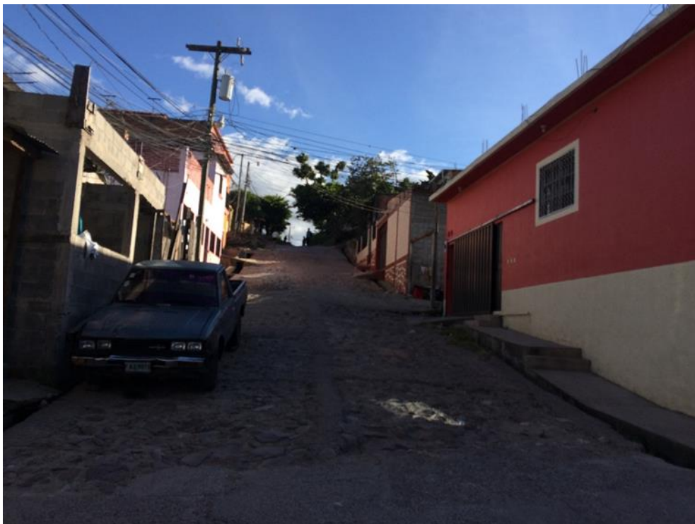
Inicio de calle a pavimentar tramo 3
