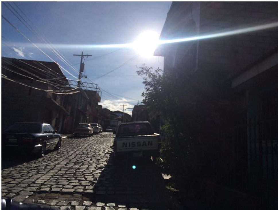
Inicio de calle a pavimentar tramo 2
