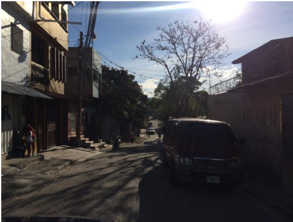
Inicio de calle a pavimentar tramo 4
