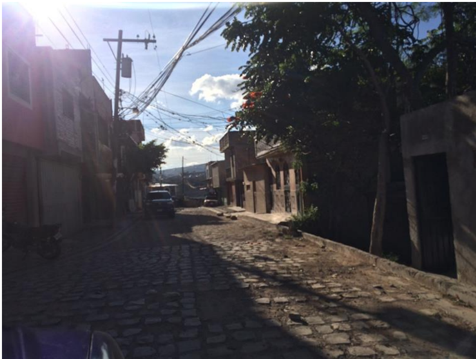
Vista de calle a reparar
