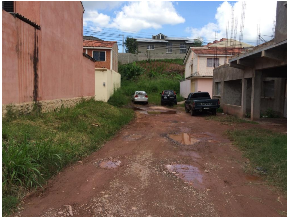
Vista final tramo 2
