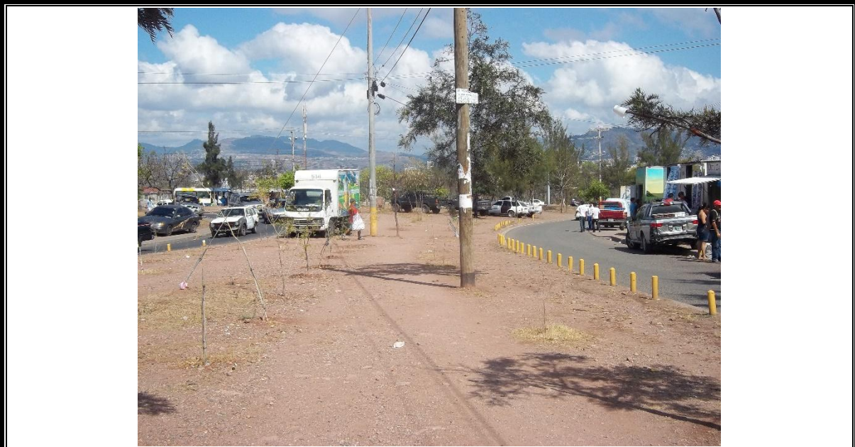
No. 2 Proyecto: RETORNO BLV FF.AA. Fecha: Mayo 2015 Fotografía mostrando área donde se ubicará el retorno desde la salida Oriente al Blv. Fuerzas Armadas.
