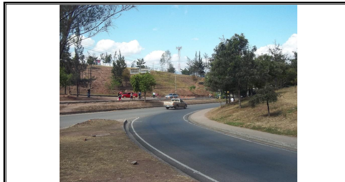
No. 4 Proyecto: RETORNO BLV FF.AA. Fecha: Mayo 2015 Fotografía mostrando antes de inicio de trabajos de ampliación de calzada.
