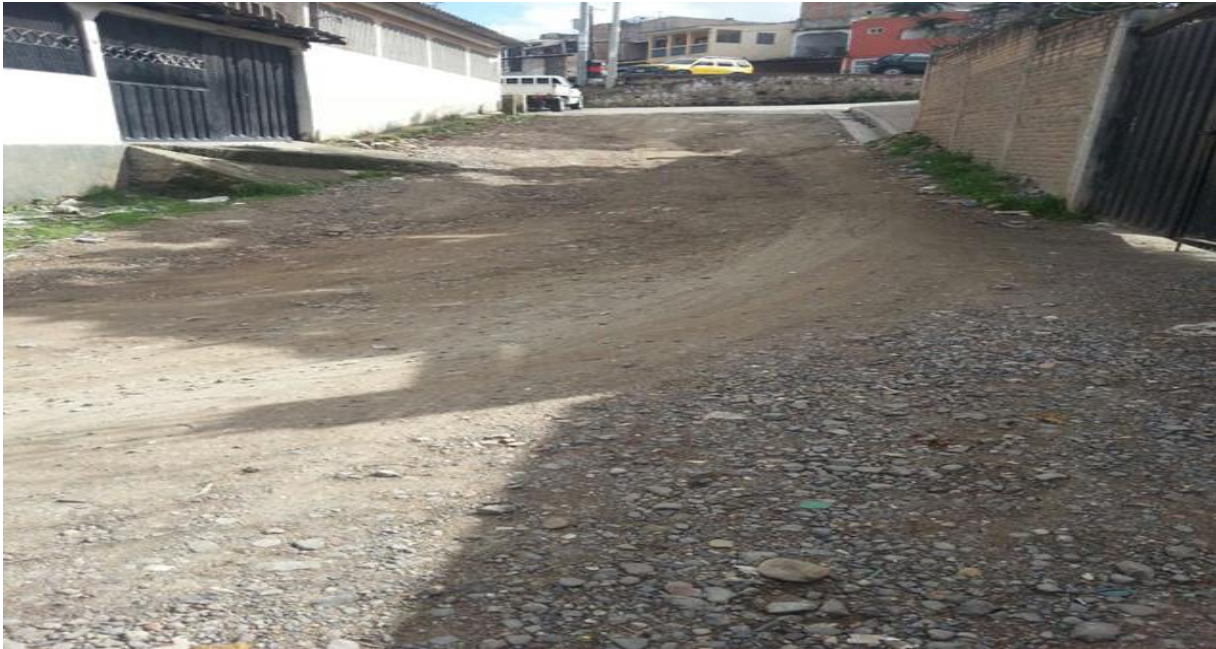
Vista de la calle a pavimentar
