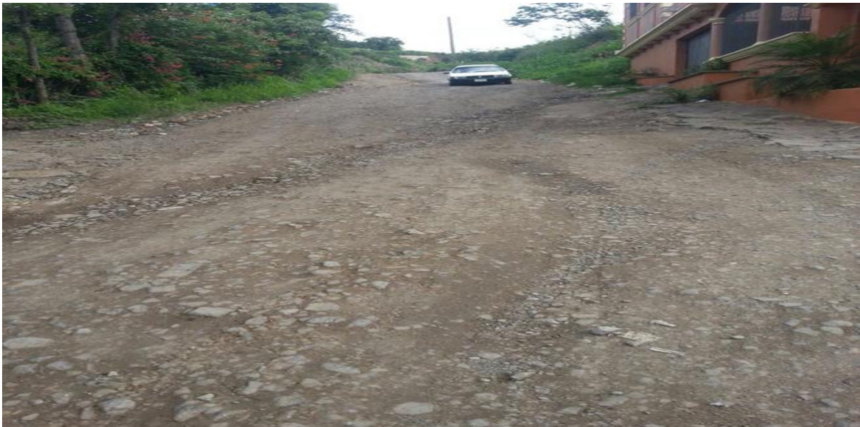
Final de calle a pavimentar
