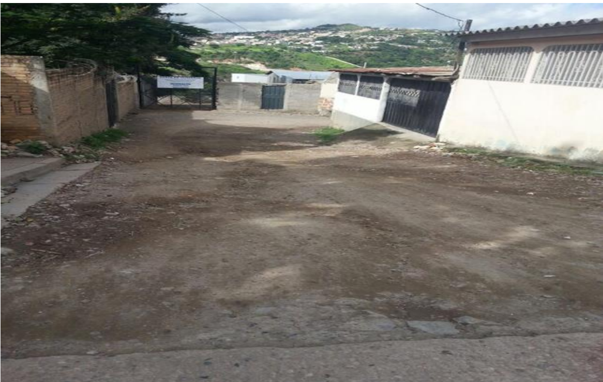
Vista panorámica de la calle a pavimentar
