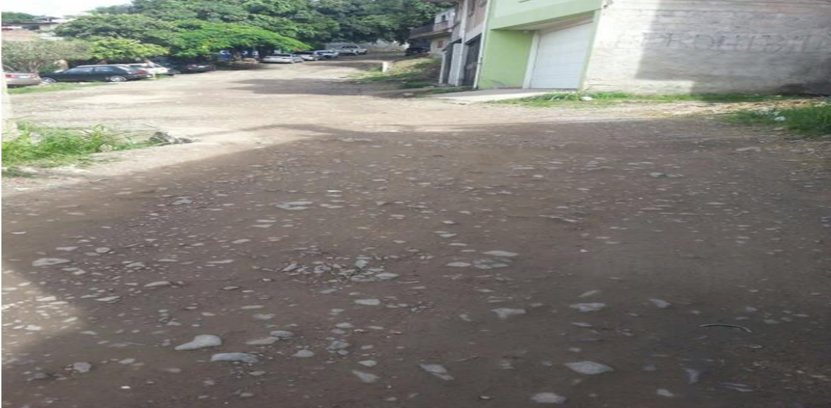
Inicio de calle a pavimentar
