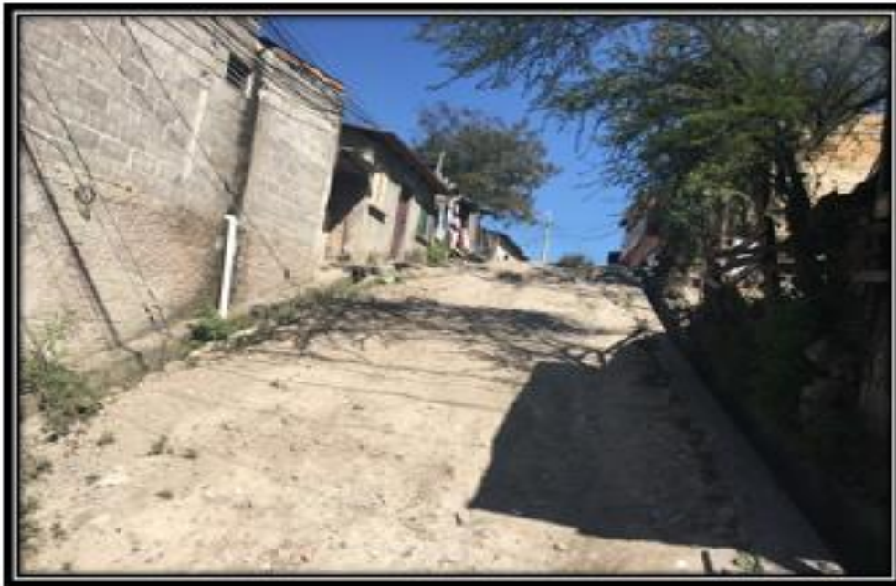
Inicio de calle a pavimentar con concreto hidráulico
