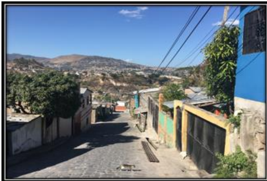
Final de calle a pavimentar con white topping
