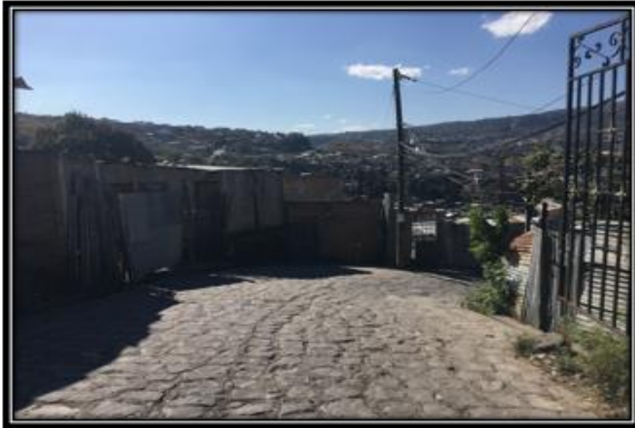
Inicio de calle a pavimentar con White Topping
